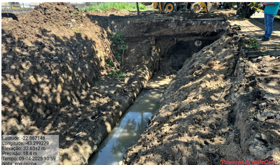
Foto 5 – Trecho escavado para reparo da adutora perto do muro de divisa
