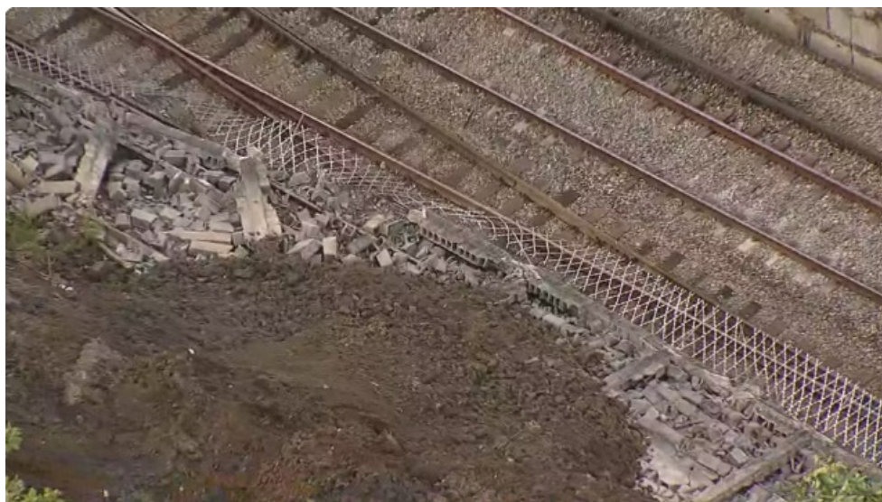
Foto 1 – Muro de divisa nos trilhos do metrô. Fonte: G1.com
