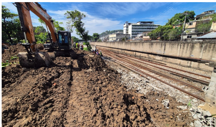
Foto 2 – Trilhos do metrô já limpos no momento da fiscalização
