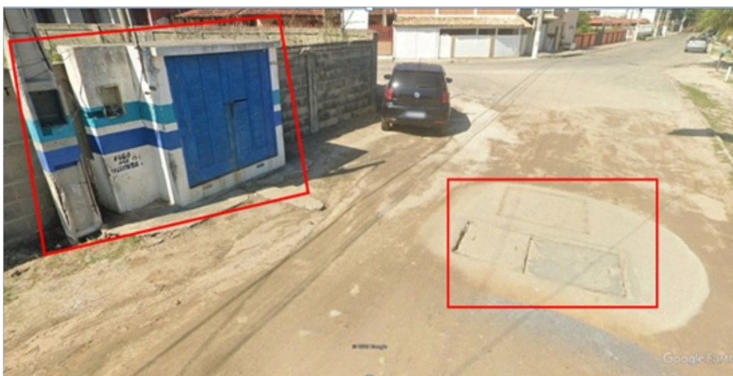
Foto 2 – Vista do tampão de concreto e do abrigo do quadro elétrico.
