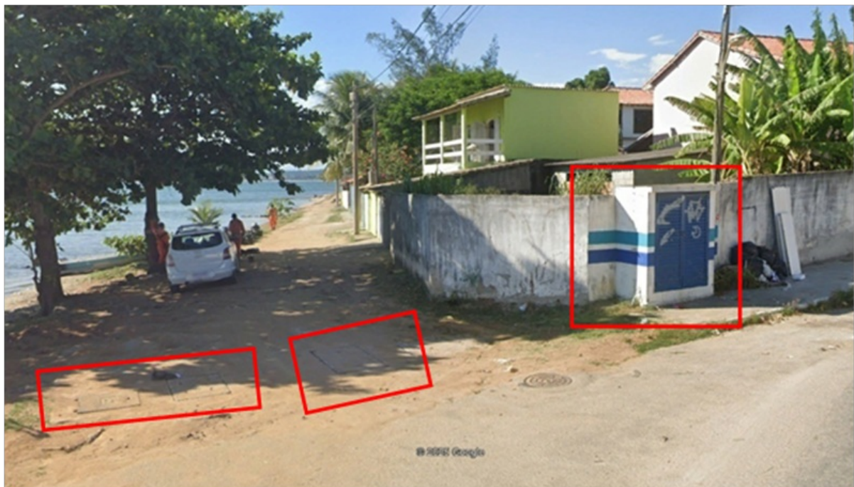
Foto 2 – Vista (da esquerda para a direita) da caixa do barrilete, poço de bombas e do abrigo do quadro elétrico (Fonte: Google Earth)
