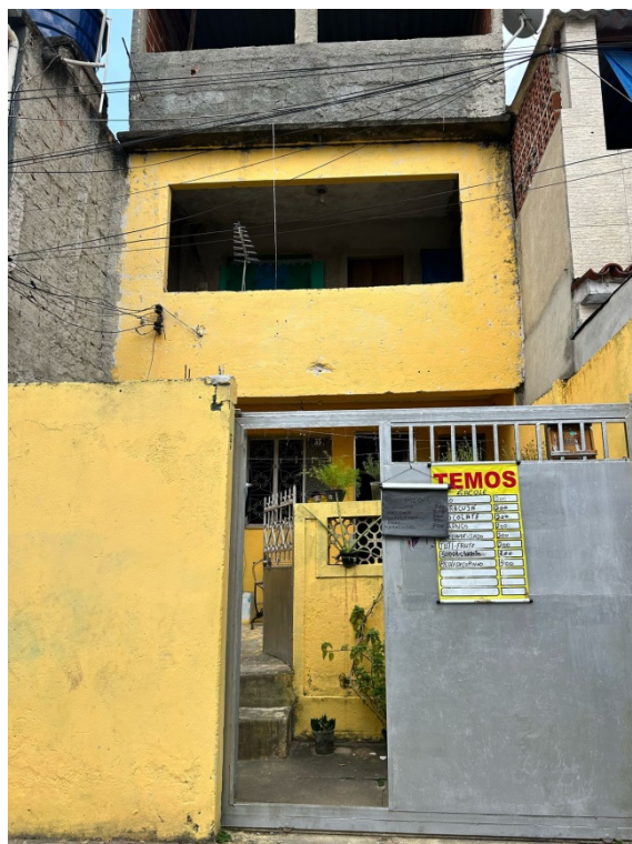
Foto 1 - Imóvel de nº 35 – Travessa Sorrento, Bangu
