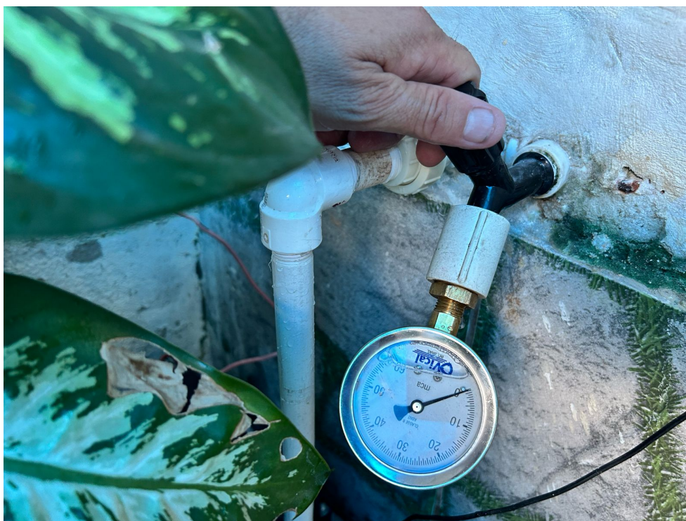
Foto 3 - Imóvel nº 9, próximo ao local da reclamação
