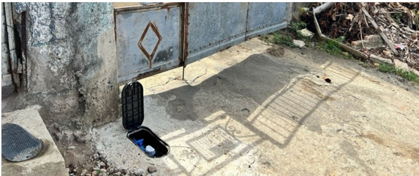
Foto 8 - Imóvel nº 36 A, Rua Macapá - Santa Cruz
