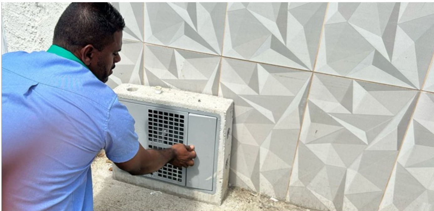
Foto 4 - Hidrômetro ligado à nova rede instalada, que se localiza na calçada do imóvel
