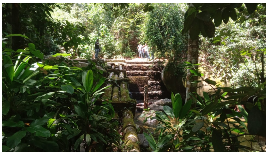
Foto 9 – Tubulação barragem / açude
