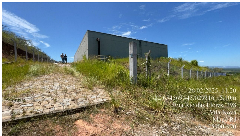
Foto 3 – Vista frontal do Reservatório
