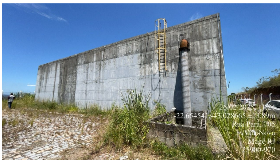
Foto 4 – Vista de fundos com escada fixa com proteção e tubulação de entrada
