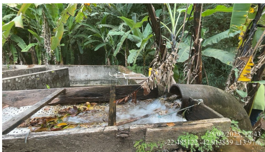
Foto 10 – Chegada da água no desarenador/tanque de contato
