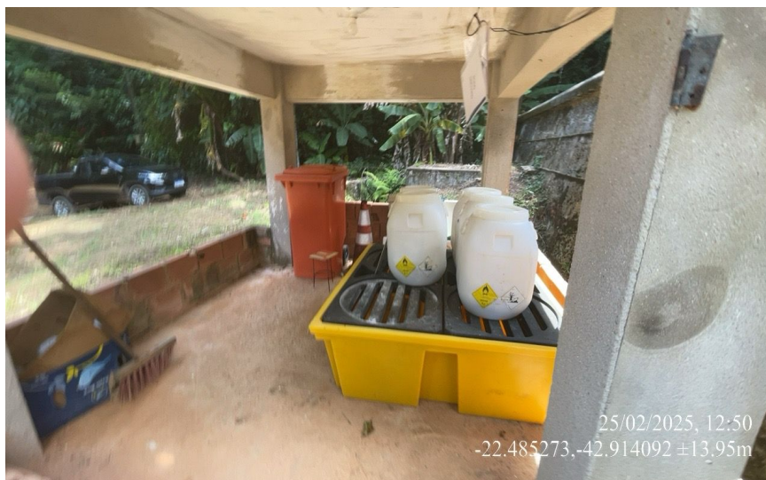
Foto 14 – Espaço para acondicionamento de produtos químicos
