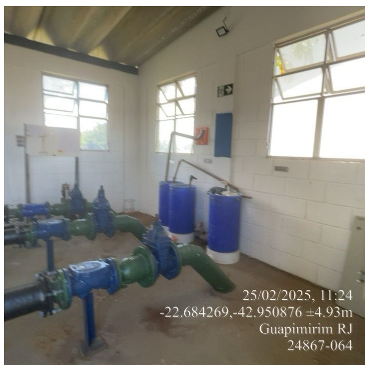
Foto 4 – Tubulação de retaguarda
