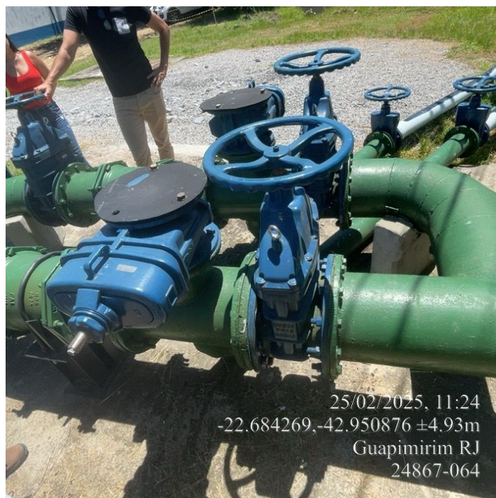
Foto 5 – Tubulação de retaguarda
