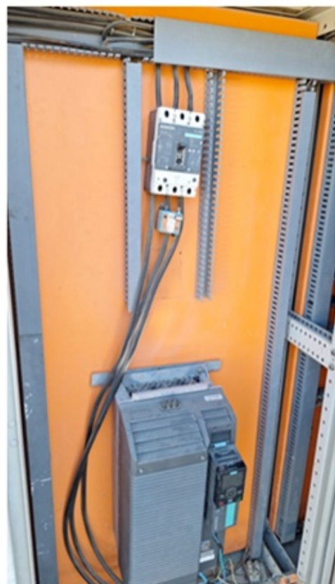
Fotos 4 e 5 – Quadro Elétrico com telemetria, proteção e inversor de frequência
