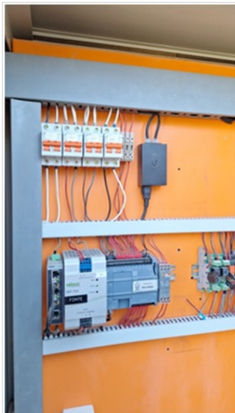
Fotos 4 e 5 – Quadro Elétrico com telemetria, proteção e inversor de frequência
