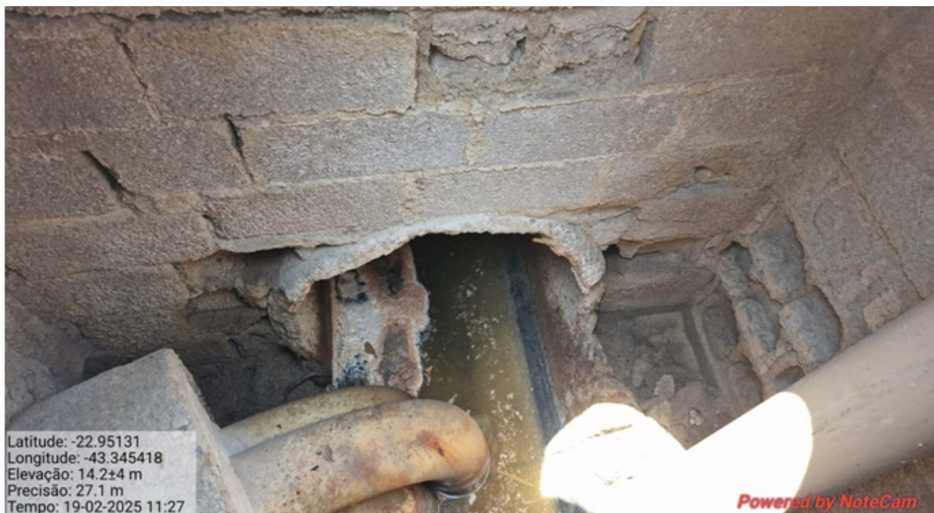
Foto 11 – Interior da caixa de areia, em frente a Empresa Rica
