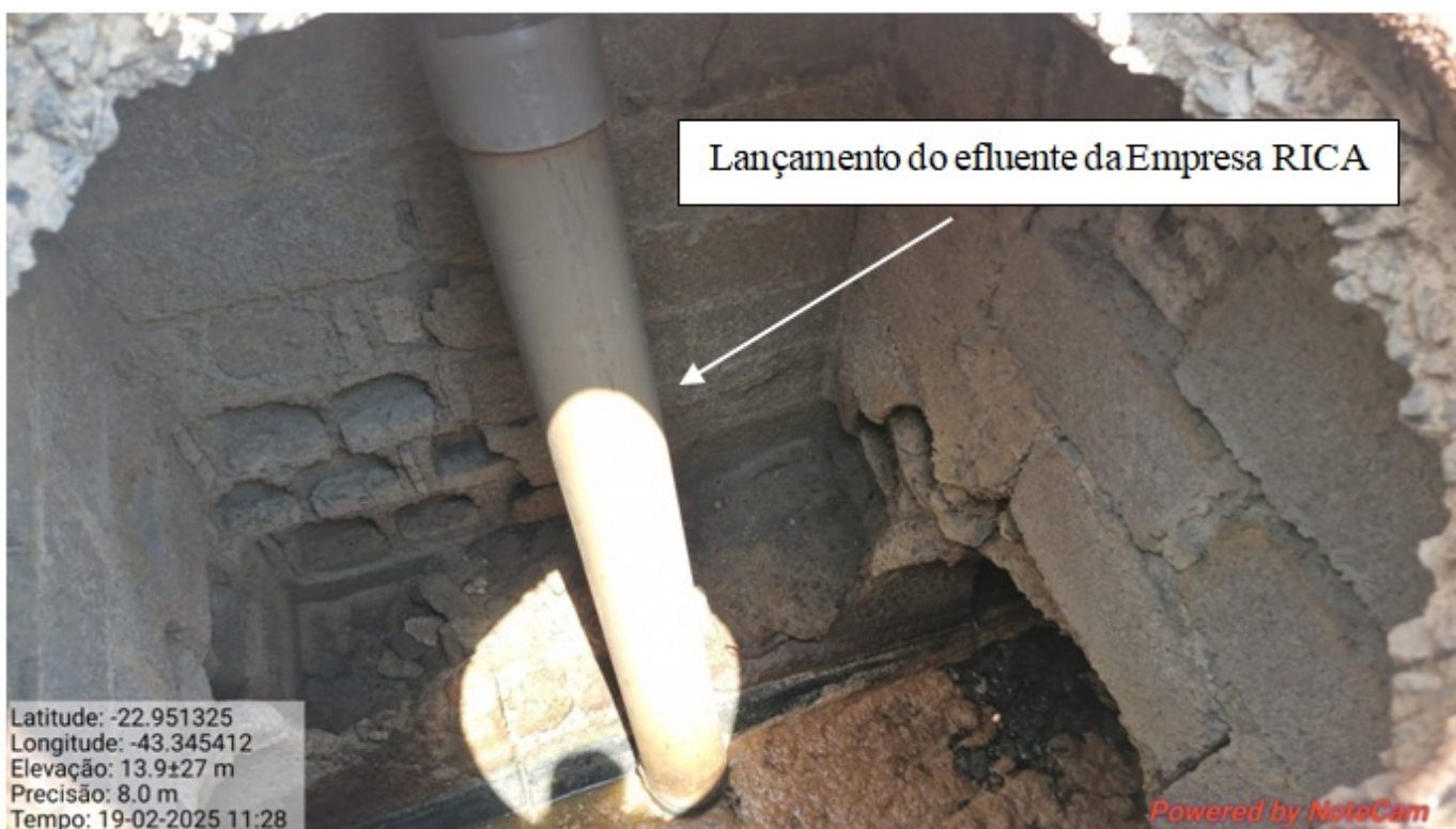
Foto 12 – Interior da caixa de areia, em frente a Empresa Rica
