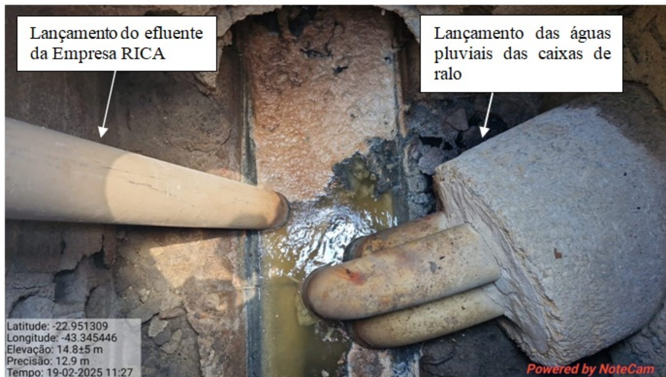
Foto 10 –Interior da caixa de areia, em frente a Empresa Rica
