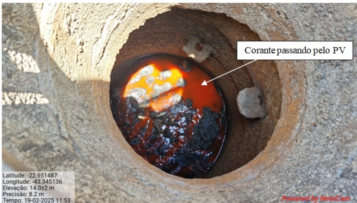
Foto 06 – Interior do 3º PV vistoriado, à jusante, já com a passagem do corante vermelho
