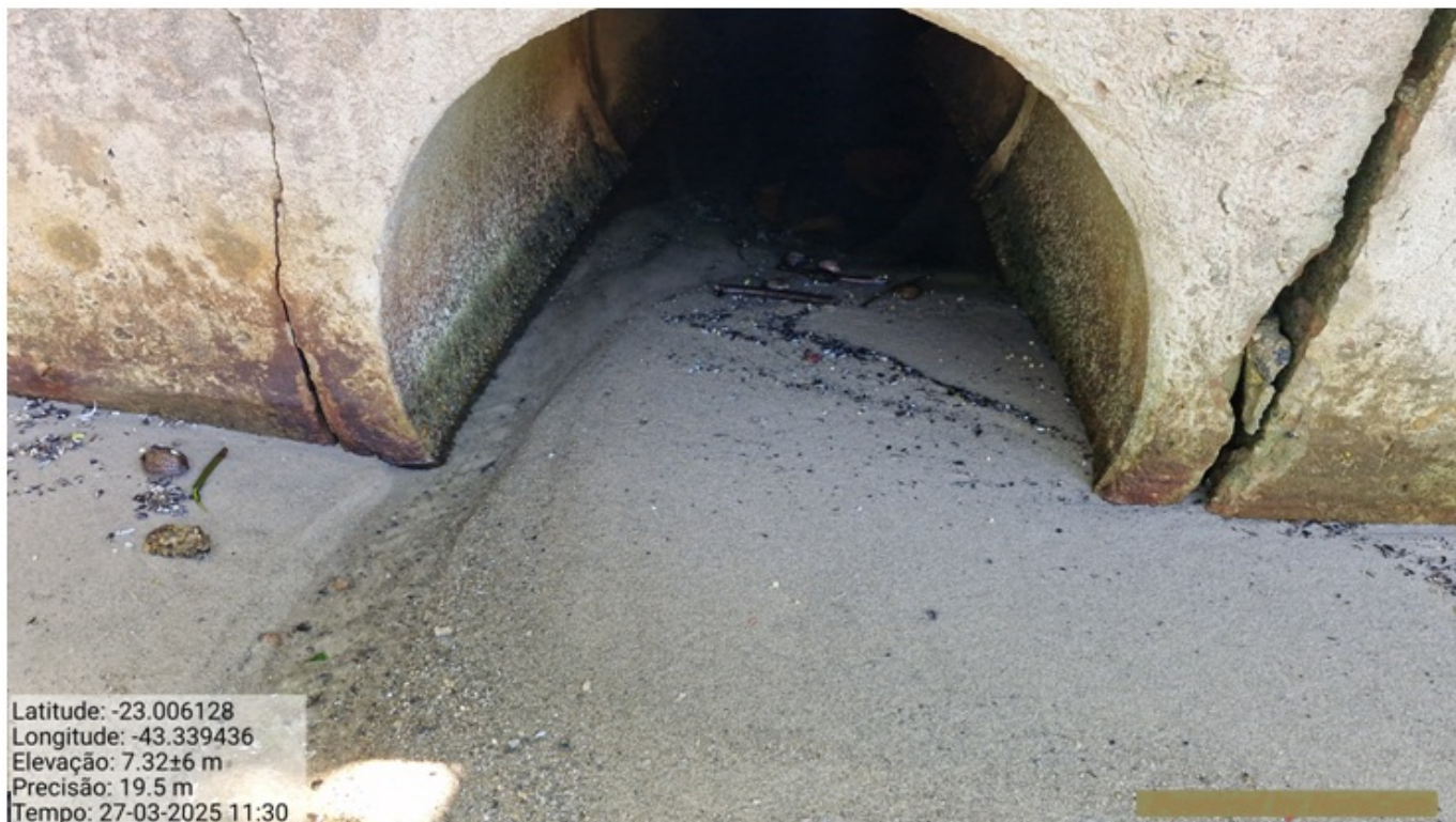
Foto 01 – Ponto de lançamento da GAP
