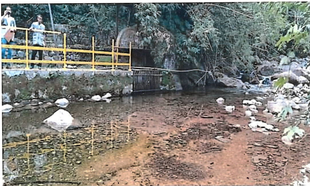
Foto 4 - Entrada de Água Bruta do Rio D'Ouro.
