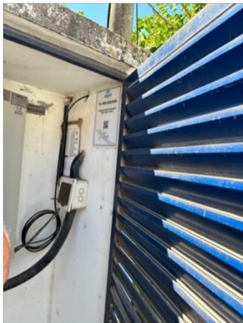
Foto 6 – Identificação da Elevatória
