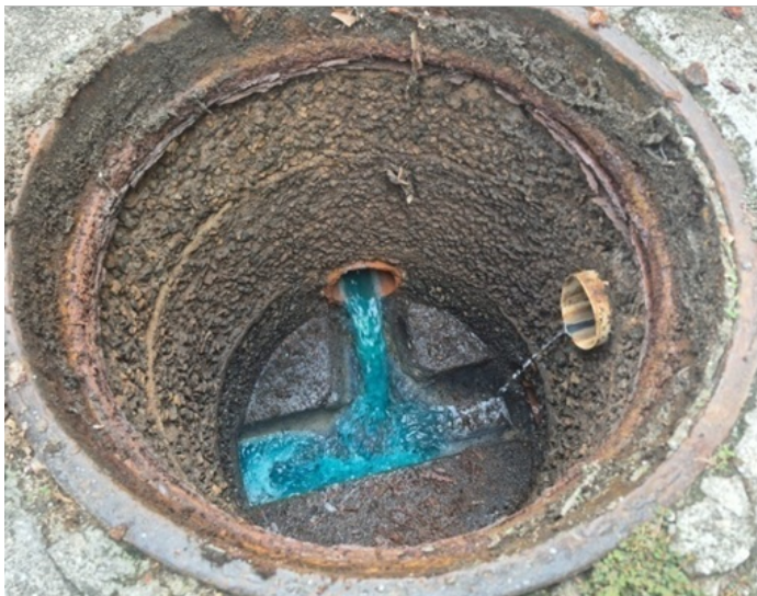
Imagem 8 - Terceira caixa de esgoto vistoriada
