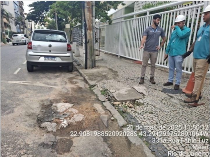
Imagem 3 – Reparo no pavimento
