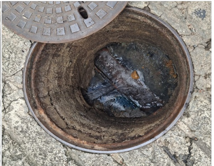
Imagem 7 - Segunda caixa de esgoto vistoriada
