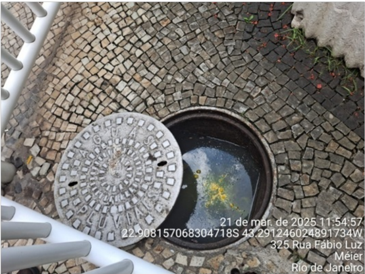
Imagem 5 - Caixa de águas Pluviais do condomínio vizinho.
