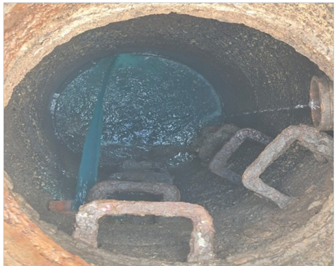
Imagem 9 - Quarta caixa de esgoto vistoriada (coletor)
