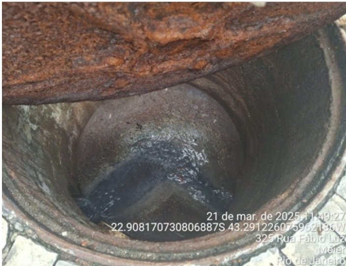
Imagem 6 – Primeira caixa de esgoto vistoriada
