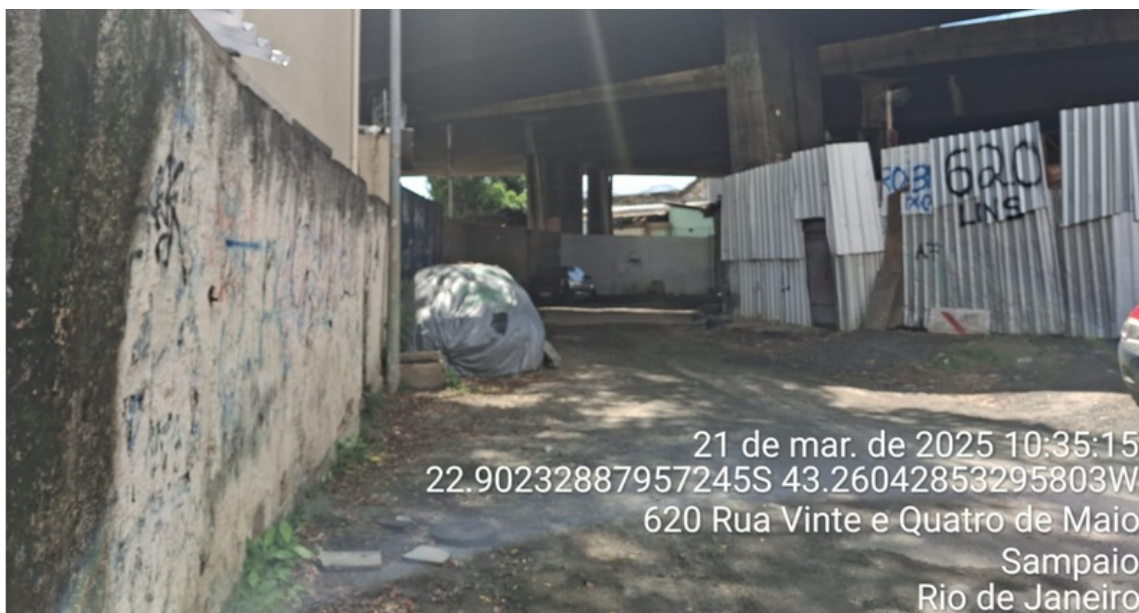
Foto 3 – Logradouro próximo ao viaduto
