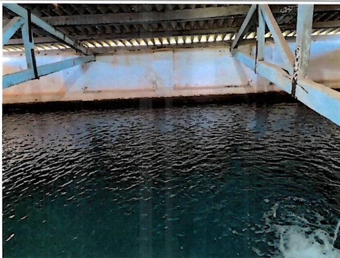
Foto 21: Vista do interior do Reservatório.
