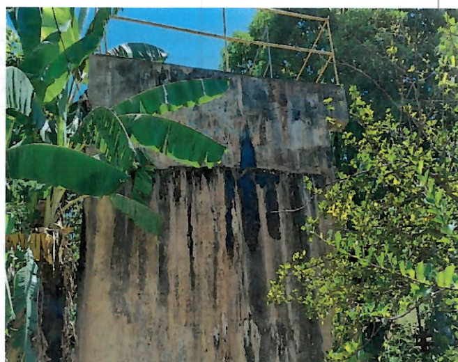
Foto 20: Vista lateral do Reservatório.
