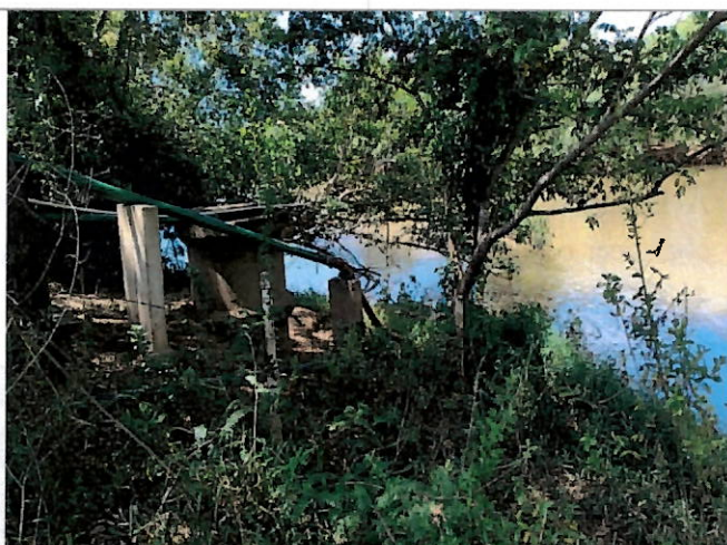
Foto 2: Vista da caixa do registro da tubulação de tomada d'água.
