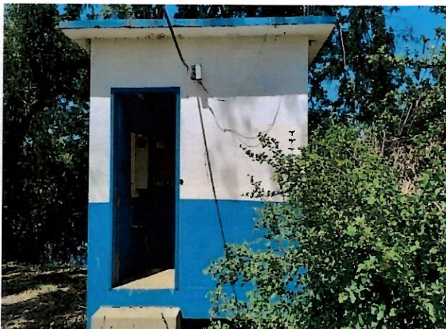
Foto 3: Abrigo do conjunto motobomba.
