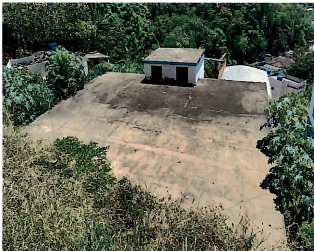
Foto 21: Vista superior do reservatório.
