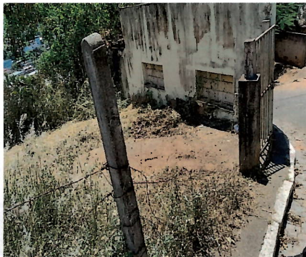
Foto 22: Acesso ao reservatório (cercamento inadequado).
