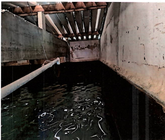
Foto 25: interior do reservatório (300 m³).
