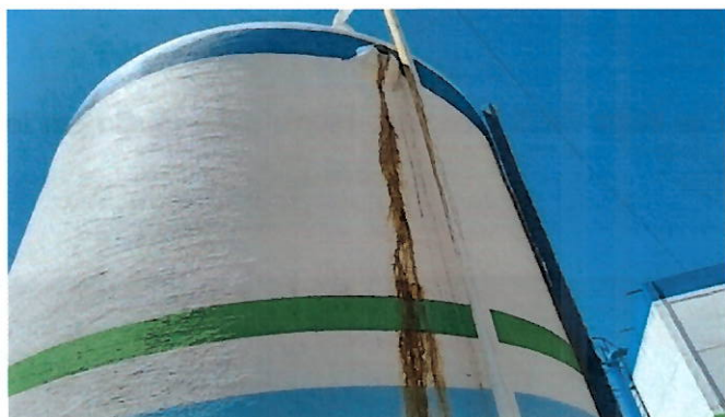
Foto 25: indícios de extravasamento do produto (parte superior).
