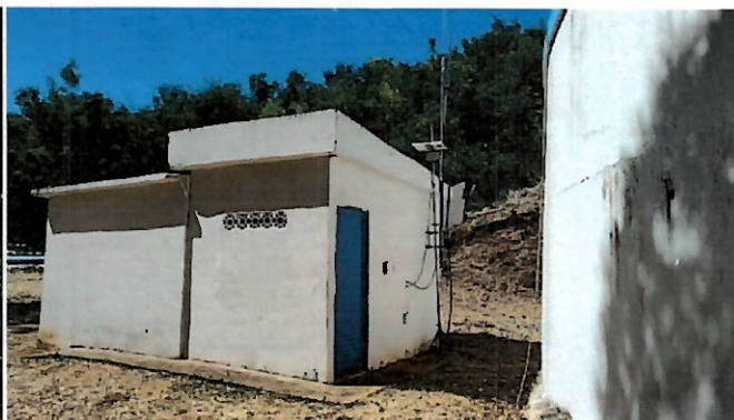
Foto 37: SPDA instalado e medidor de nível automático.
