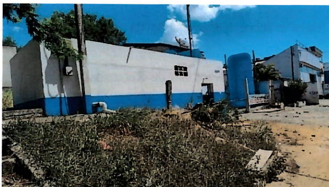
Foto 48: abrigo do painel elétrico.
