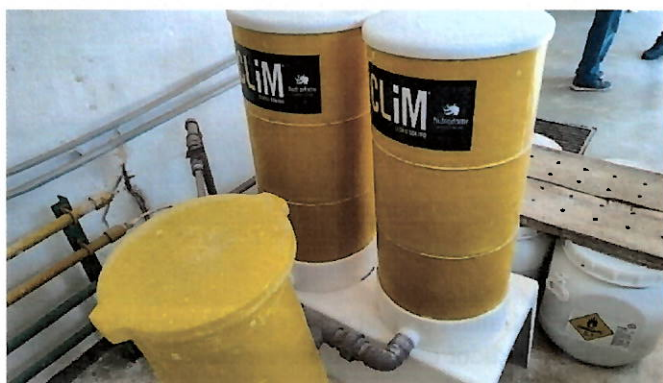
Foto 17: sistema de cloração com Hipoclorito de Cálcio.
