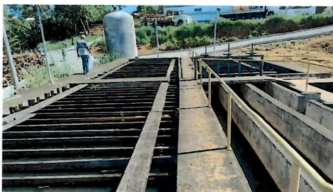
Foto 13: Floculador com chicanas de madeira.
