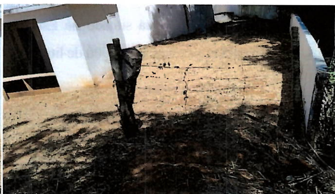
Foto 35: Entrada do Reservatório Central – muros baixos e porteira de arame farpado.
