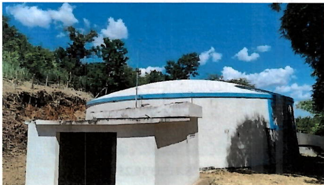
Foto 36: Vista do reservatório.
