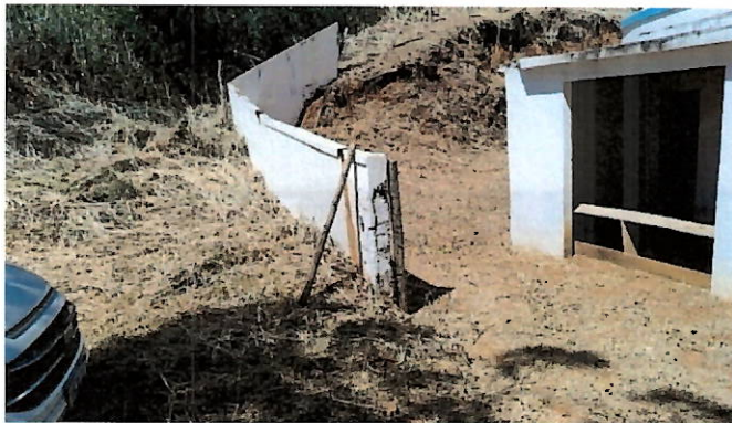
Foto 34: Entrada do Reservatório Central – muros baixos e porteira de arame farpado.
