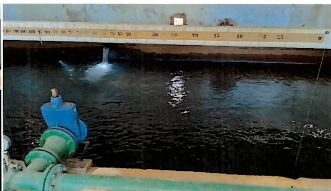
Foto 45: reservatório de água.
