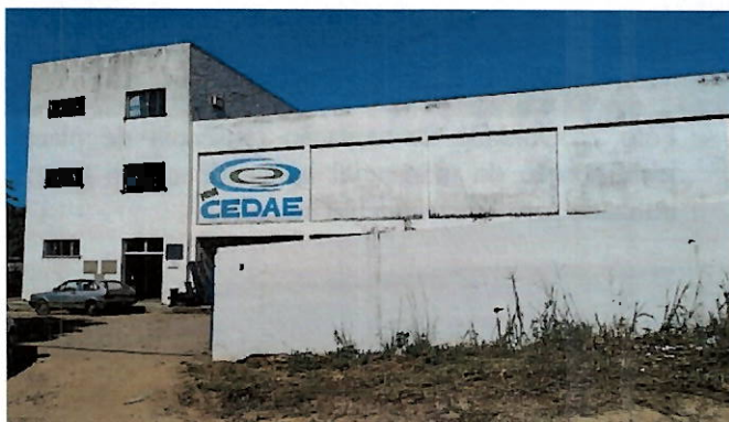
Foto 7: Entrada da ETA Itaperuna (ausência de placa de identificação da ETA).
