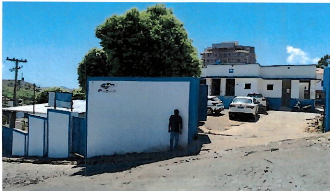
Foto 42: Entrada do reservatório.
