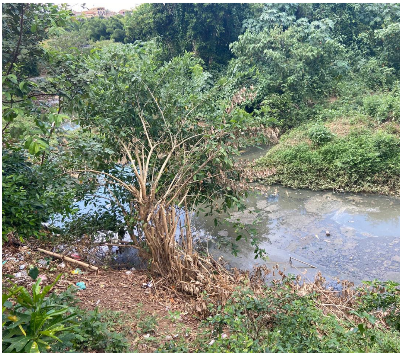
FOTO 08 – Estrada Velha Vieira Cortez, nº 601 – fundos, esgoto escoando para o Rio Paraíba do Sul.
