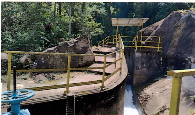
Foto 7: Canal de entrada de água no sistema.
