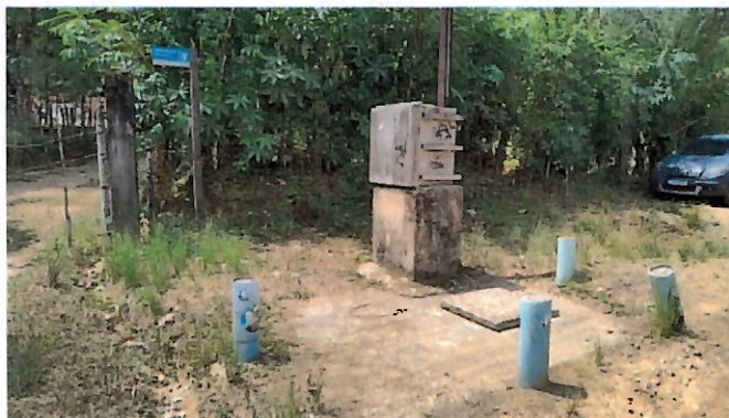
Foto 19: Macromedidor - Ponto de medição de vazão (CEDAE).
