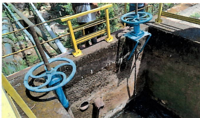
Foto 8: Transferência de água do canal para adutoras.
