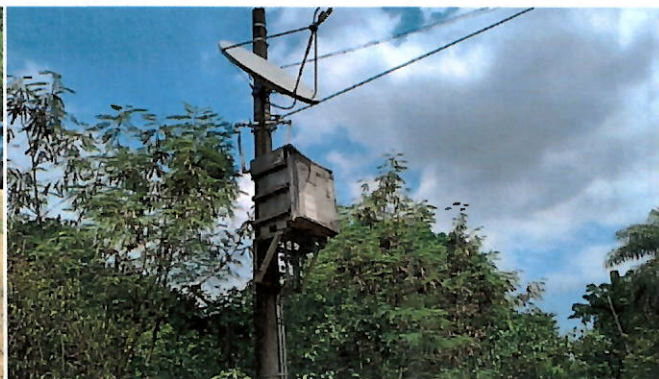
Foto 20: Macromedidor – equipamento de telemetria (CEDAE).
