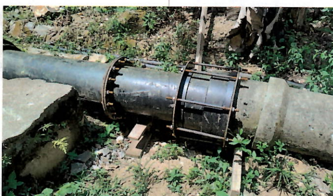
Foto 10: Reparo realizado em adutora (ausência de vazamento aparente).
