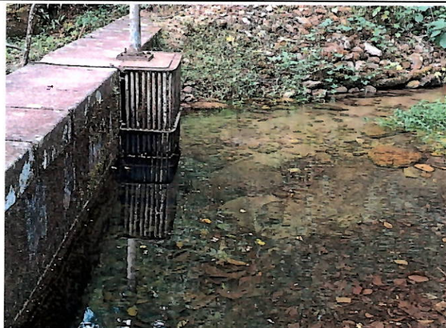
Foto 23: Gradeamento da barragem.
