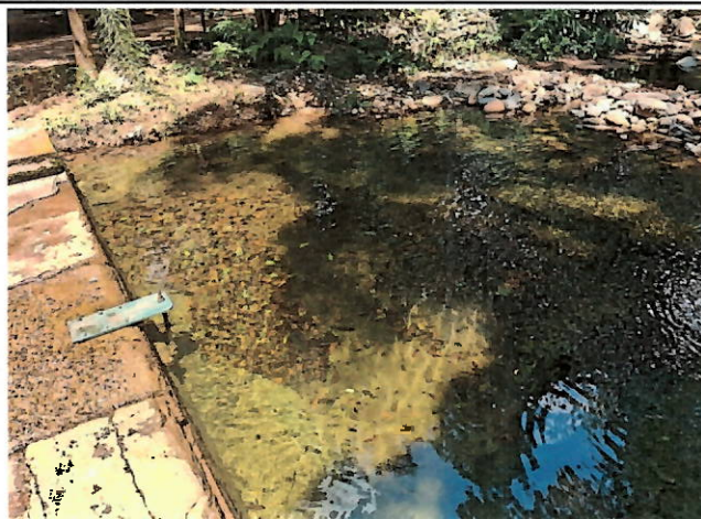
Foto 15: Acúmulo de sedimentos e matéria orgânica no poço.
