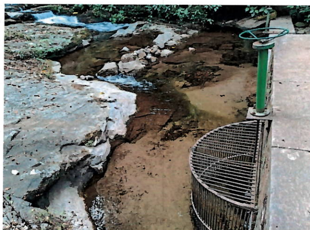
Foto 19: Gradeamento da barragem.
