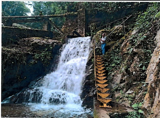
Foto 1: Acesso para captação com vistas do guarda-corpo.
