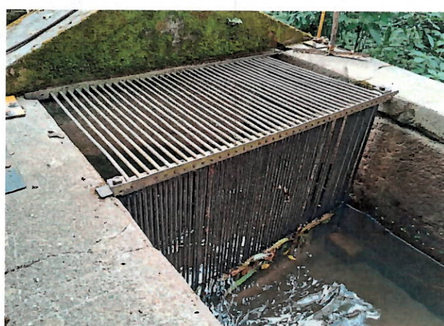
Foto 6: Gradeamento ao final da canaleta.
