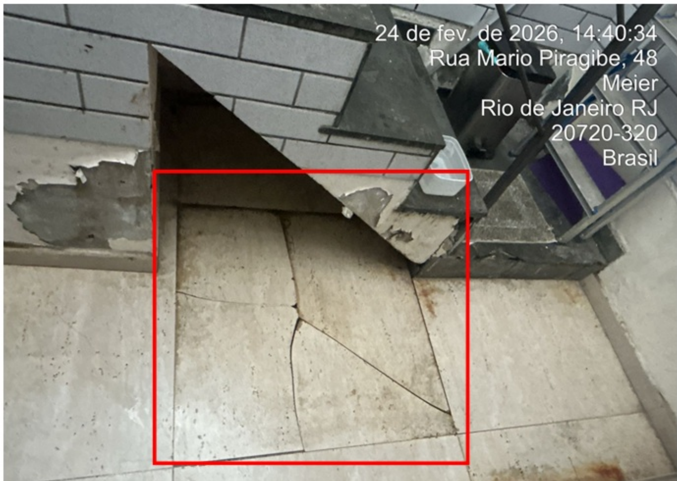
Foto 04 – Localização da caixa de inspeção interna do imóvel
