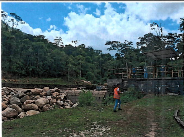
Foto 1: Acesso para captação com vistas do guarda-corpo.
