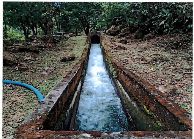
Foto 13: Túnel canal. Transporta água captada para a caixa de areia.
