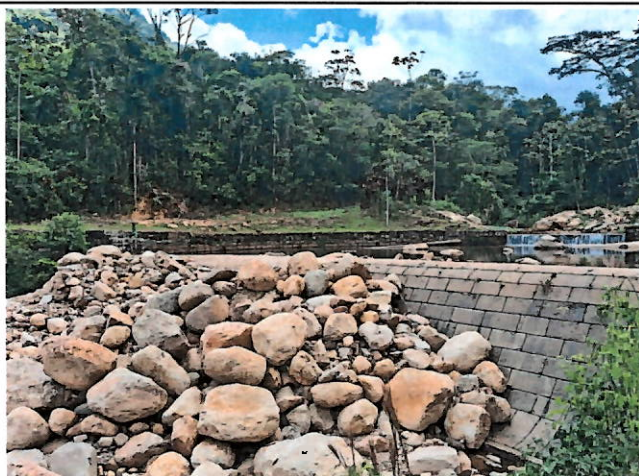
Foto 2: Rochas retiradas do poço e depositadas em frente à barragem.
