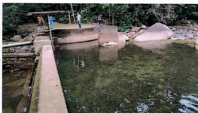
Foto 9: Baixo nível de água na represa.
