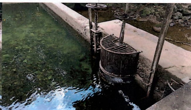
Foto 10: Sistema de abertura e fechamento de comportas.
