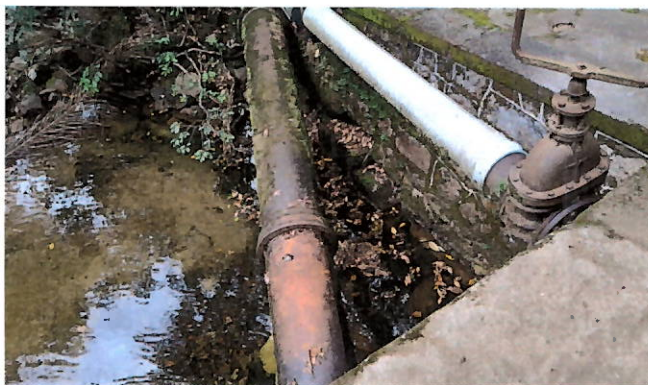
Foto 11: Adutoras de água bruta.
