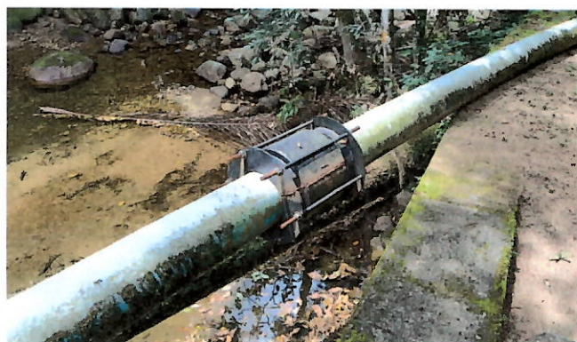
Foto 12: Reparo realizado em adutora (ausência de vazamento).
