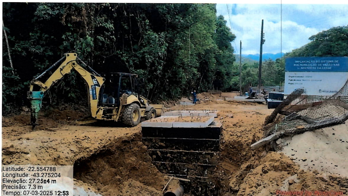
Foto 21: Obra para implantação de sistema de macromedição de vazão (CEDAE).
