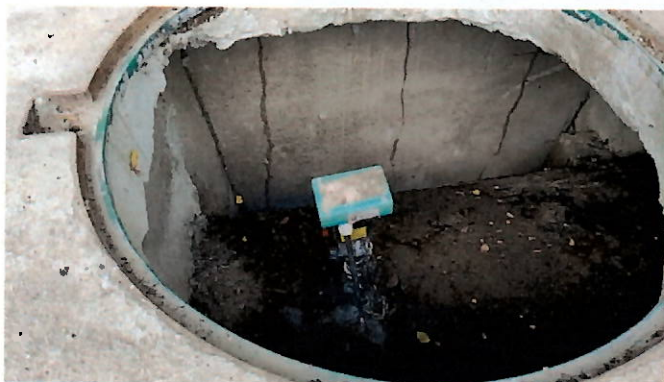
Foto 25: Ponto de medição de vazão (macromedidor de inserção).
