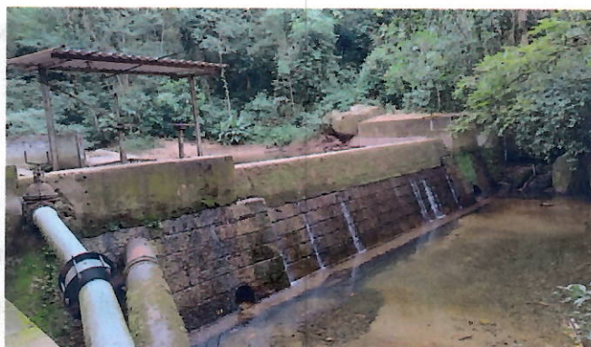
Foto 8: Barragem do Meio.
