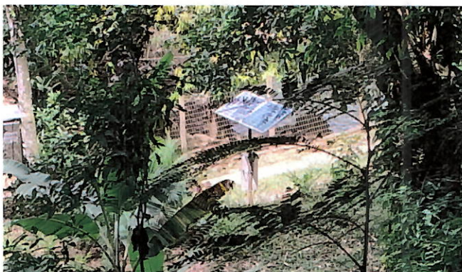
Foto 19: Ponto de medição de vazão.
