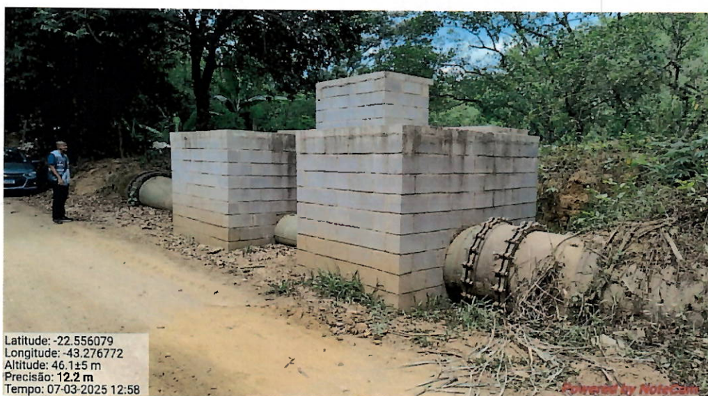
Foto 22: Sistema de macromedição da concessionária Águas do Rio.
