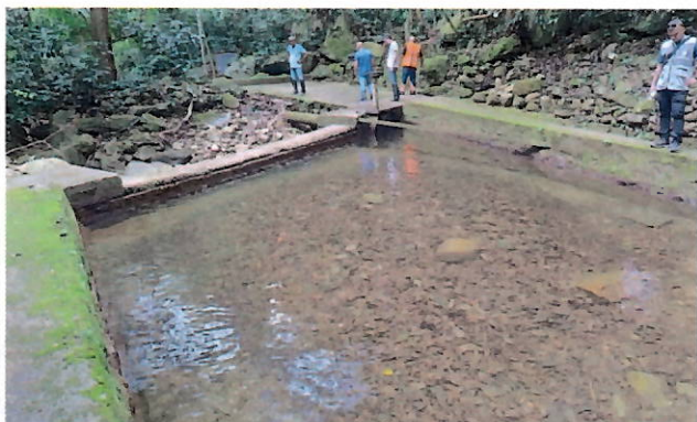
Foto 15: Baixo nível de água na represa.
