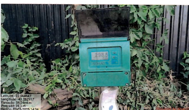
Foto 28: Pitot Eletromagnético (298 L/s)
