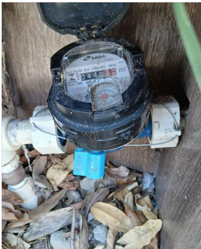
Foto 6 – Selagem das virolas do hidrômetro
