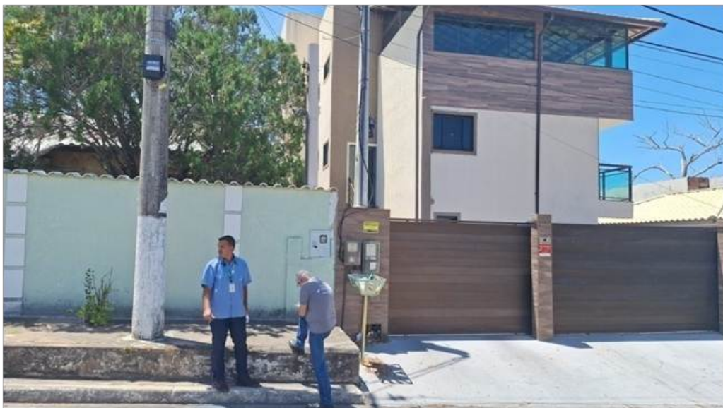
Foto 3 – Fachada do imóvel
