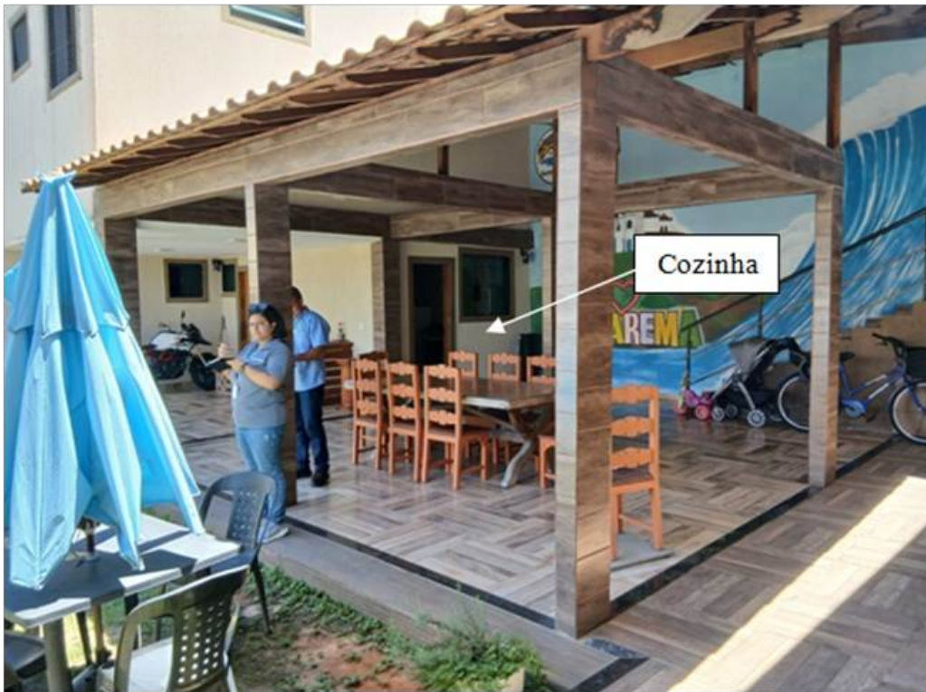
Foto 11 – Área de convivência e cozinha no fundo
