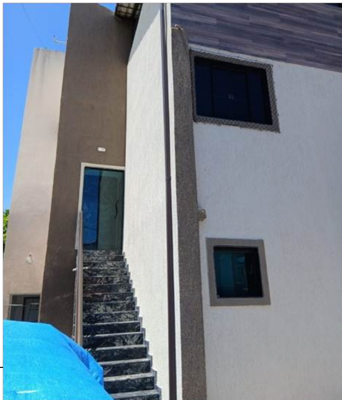
Foto 23 – Acesso à residência
