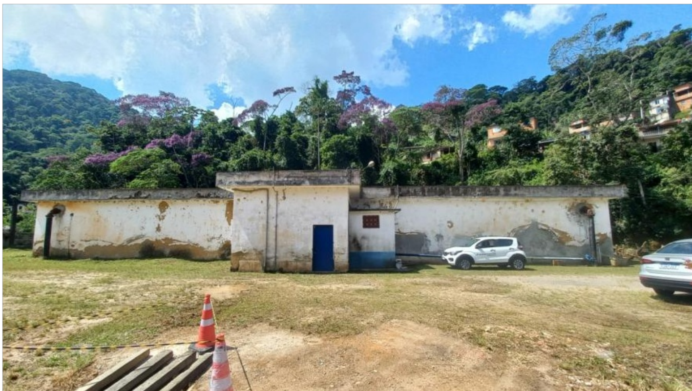
Foto 1 – Estrutura do reservatório
