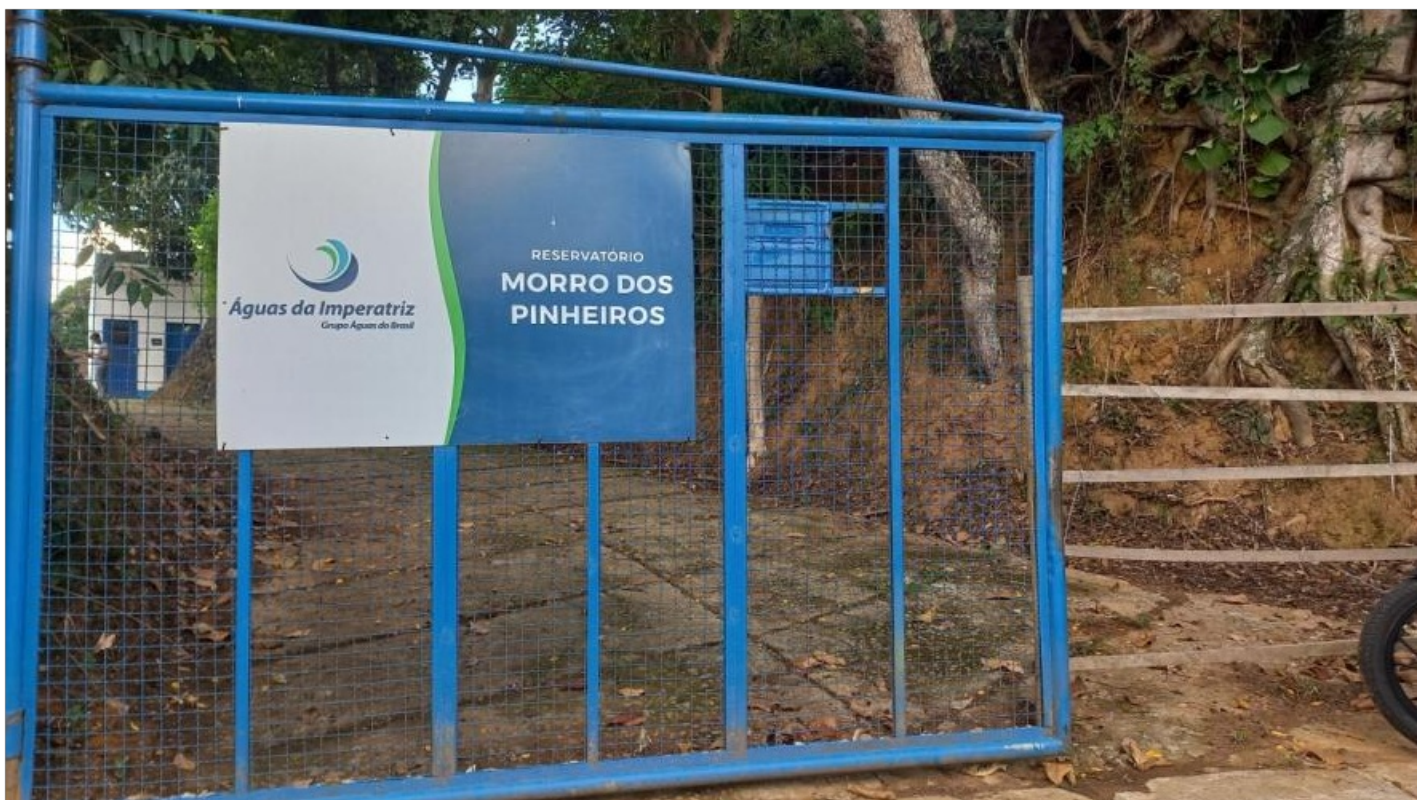
Foto 8 – Entrada do reservatório
