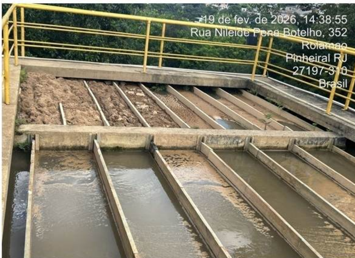
Foto 15 – Floculadores com bastante sedimentação em superfície e presença de vegetação
