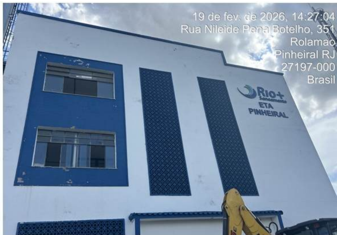
Foto 12 - Identificação da ETA Pinheiral
