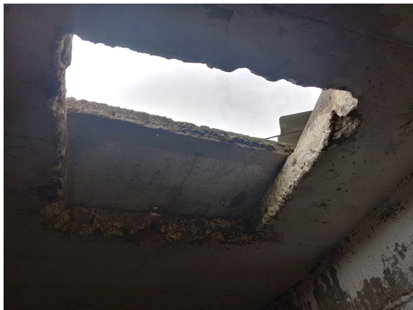
Foto 3 – Visita na laje
