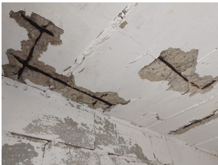
Foto 3 – Visita na laje
