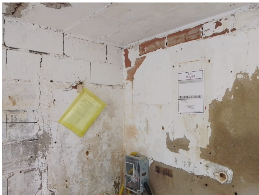
Foto 9 – Identificação presa na parede
