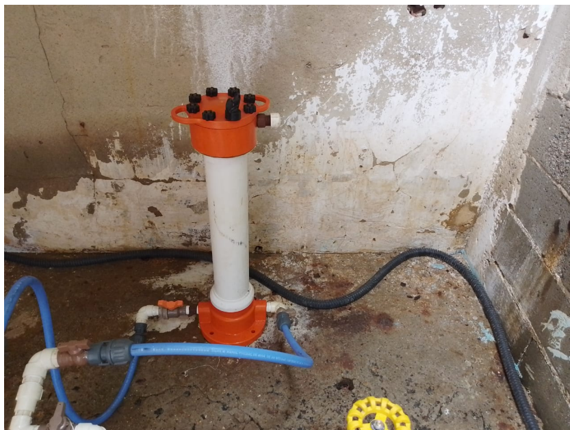
Foto 7 – Parede com pintura desgastada
