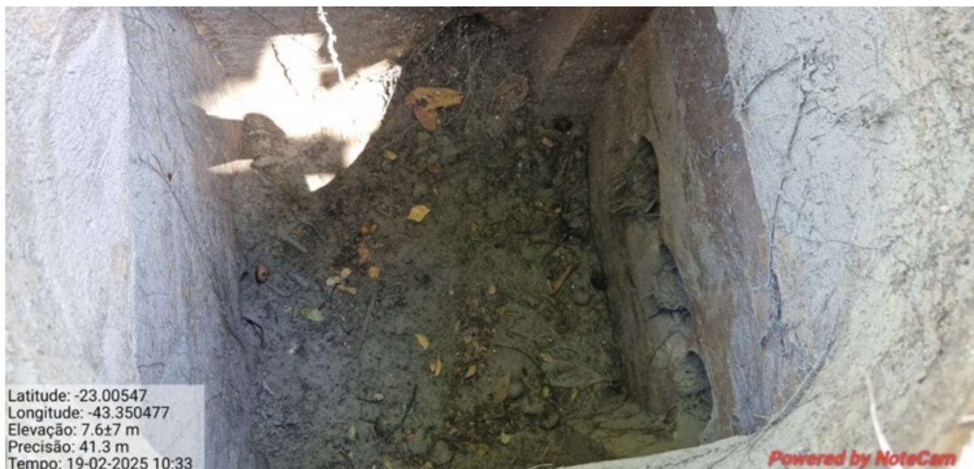
Foto 01 – Galeria de Águas Pluviais
