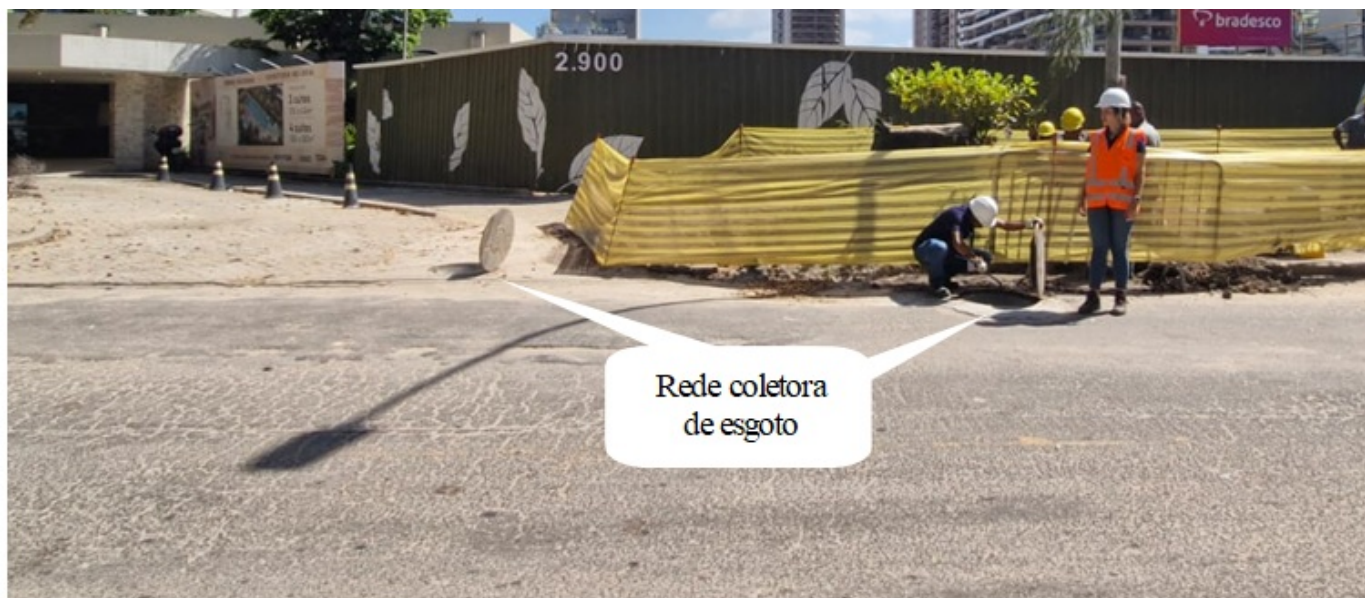
Foto 03 –Vista da frente do empreendimento (rede coletora de esgoto)
