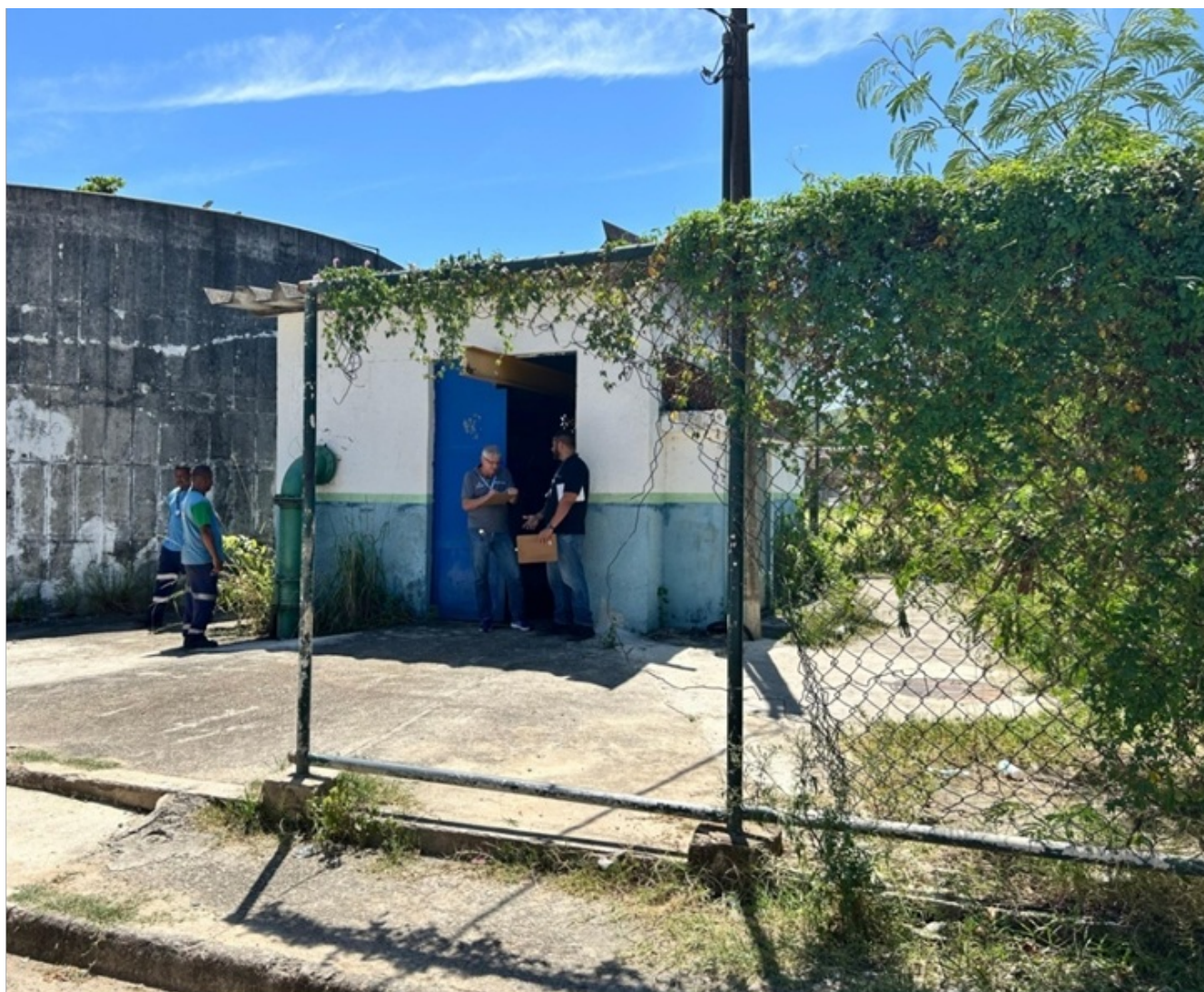
Foto 1 - Localização da EEAT com visualização dos gradis quebrados e sem identificação da unidade
