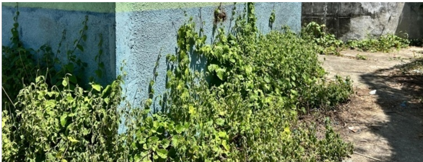
Foto 3 - Presença de vegetação ao redor do abrigo da EEAT
