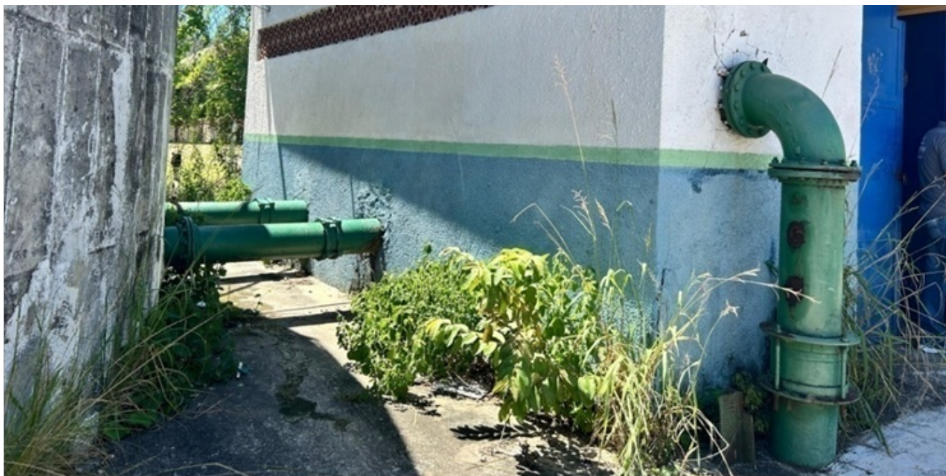
Foto 2 - Presença de vegetação ao redor do abrigo da EEAT
