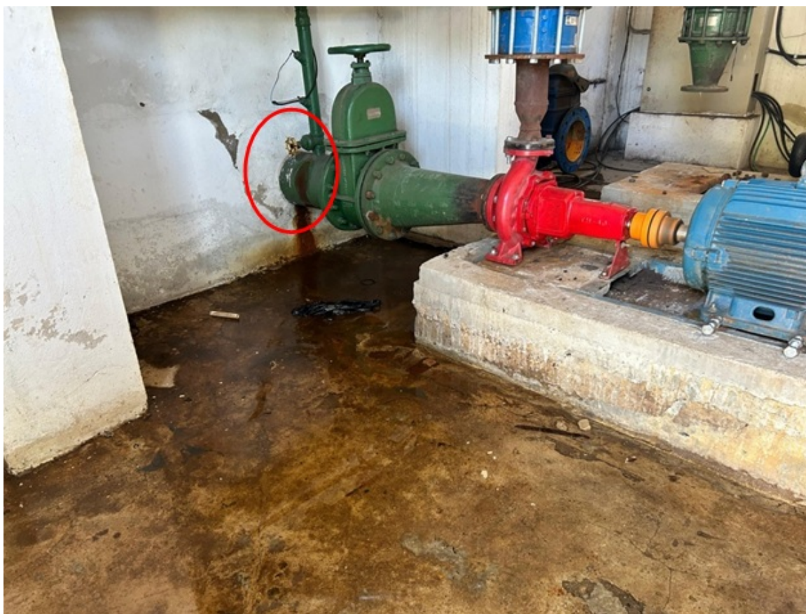
Foto 7 - Vazamento identificado em uma válvula e com presença significativa de água no chão da unidade
