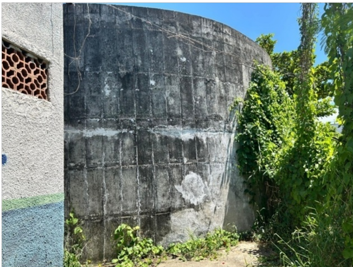
Foto 14 - Parte detrás do reservatório com presença de bastante vegetação
