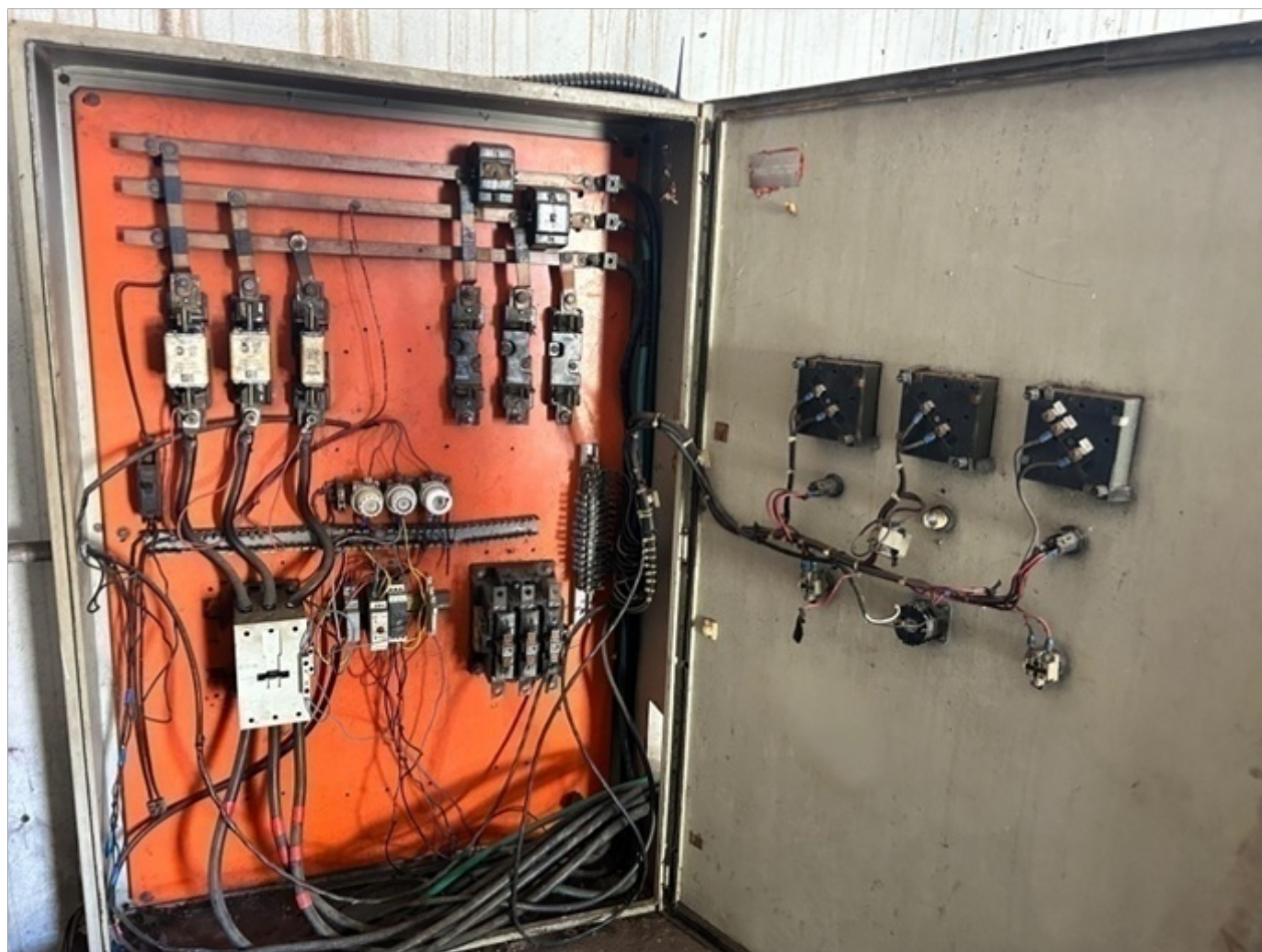
10 - Interior do abrigo
