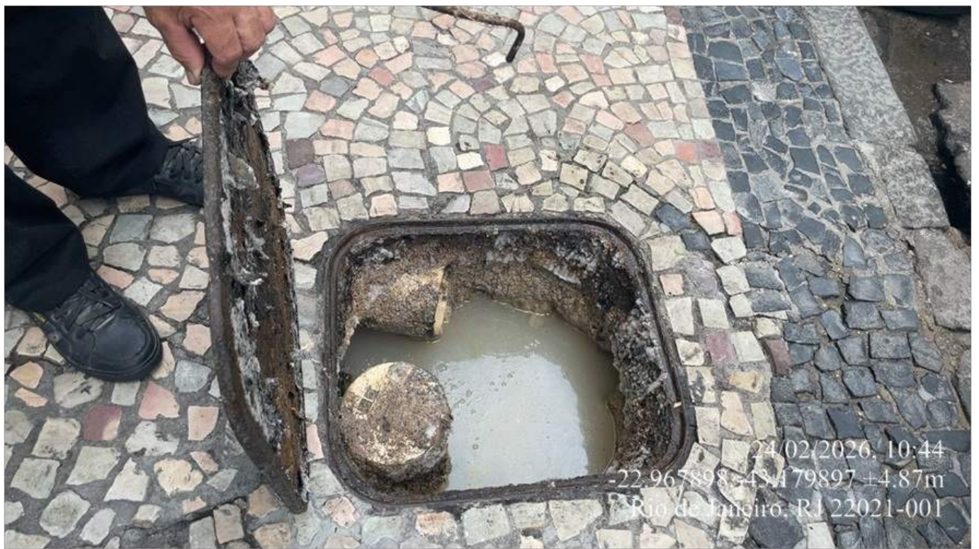
Foto 3 – Caixa de Inspeção (CI) do imóvel
