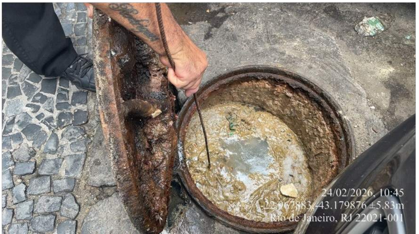
Foto 4 – Poço de Visita (PV)
