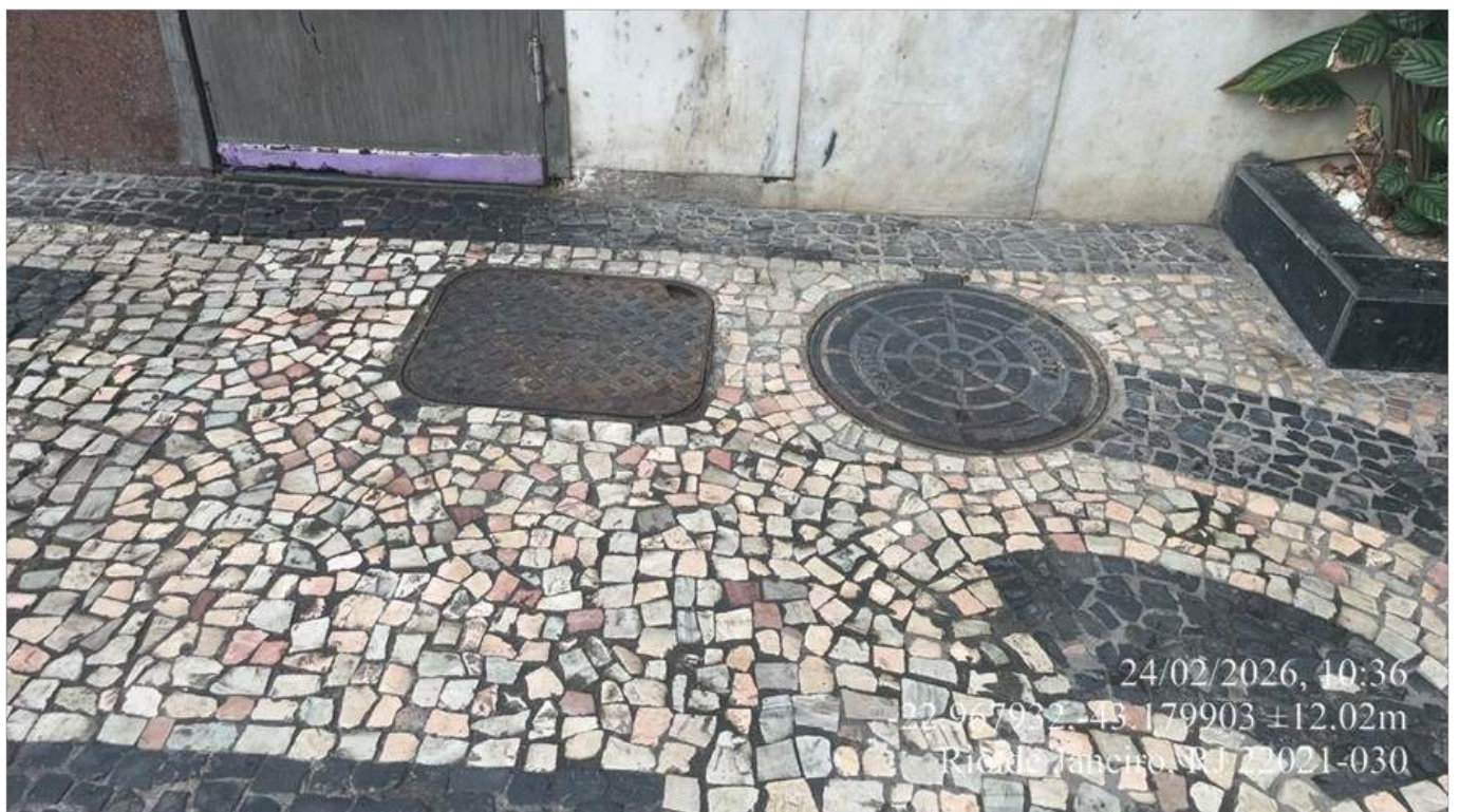
Foto 2 – Caixa de gordura e saída de esgoto do restaurante
