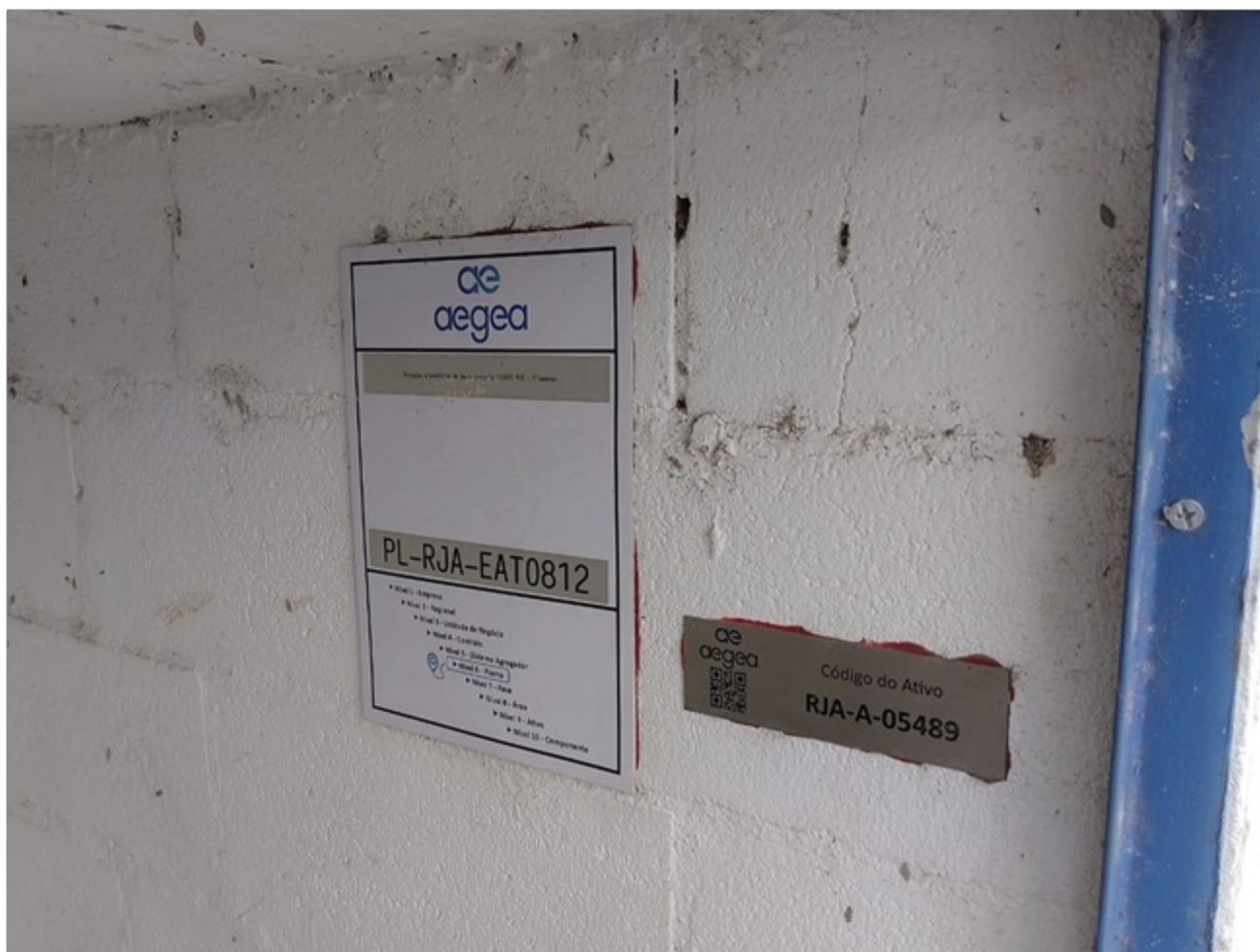
Foto 7 – Identificação da unidade (EEAT)
