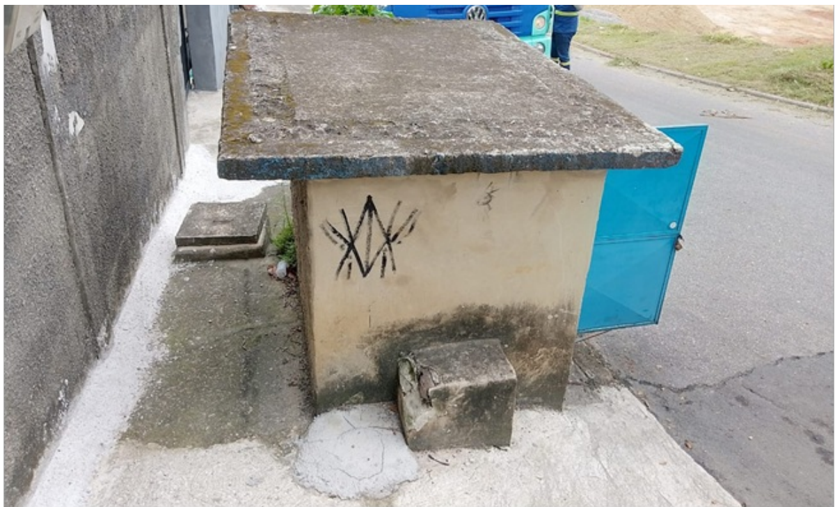
Foto 1 – Abrigo da elevatória situado no passeio público
