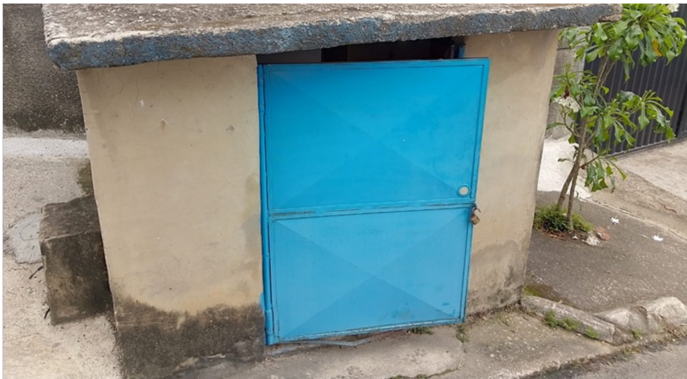
Foto 3 – Abrigo da elevatória sem identificação, mas com acesso restrito
