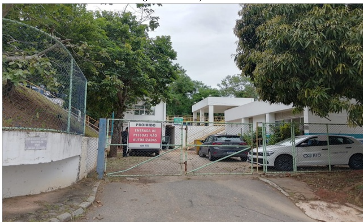
Foto 1- Entrada principal da Estação de Tratamento
