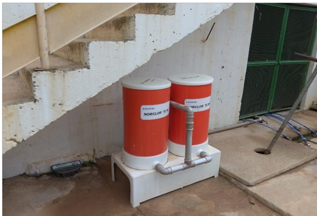
Foto 13 - Sistema de aplicação de cloreto de cálcio em pastilhas
