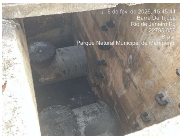
Figura 9: Caixa de transição à jusante da travessia na Lagoa de Marapendi.
