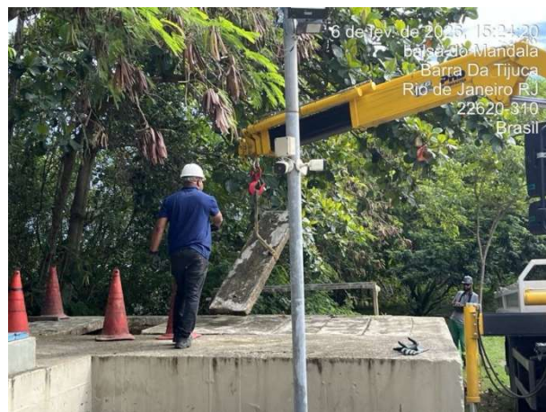
Figura 2: Maquinário retirando a tampa de concreto da caixa.
