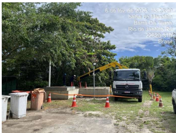
Figura 1: Caixa de transição à montante da travessia na Lagoa de Marapendi.
