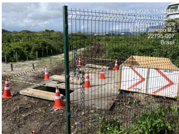
Figura 7: Caixa de transição à jusante da travessia na Lagoa de Marapendi.
