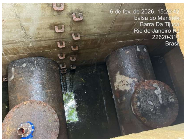
Figura 3: Interior da caixa de transição à montante da travessia na Lagoa de Marapendi.
