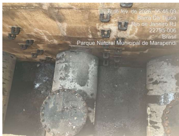
Figura 10: Interior da caixa de transição à jusante da travessia na Lagoa de Marapendi.
