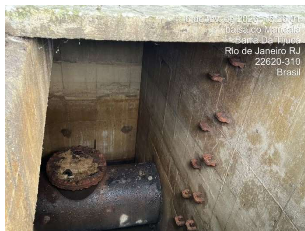
Figura 4: Interior da caixa de transição à montante da travessia na Lagoa de Marapendi.
