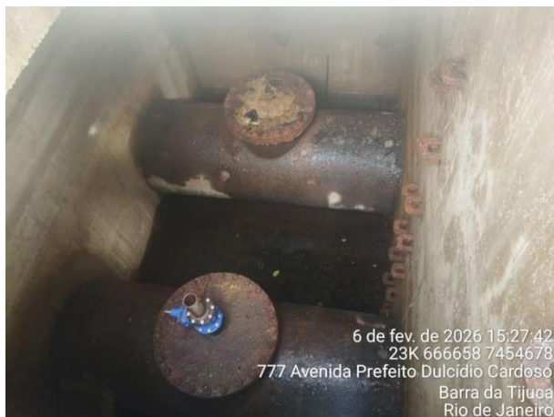
Figura 5: Interior da caixa de transição à montante da travessia na Lagoa de Marapendi.
