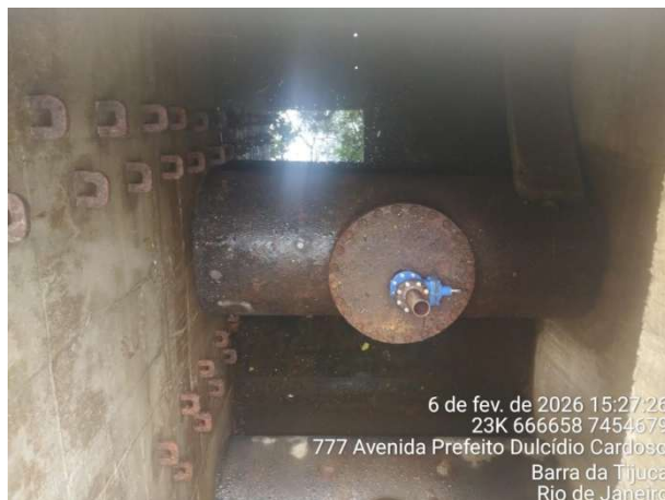
Figura 6: Interior da caixa de transição à montante da travessia na Lagoa de Marapendi.
