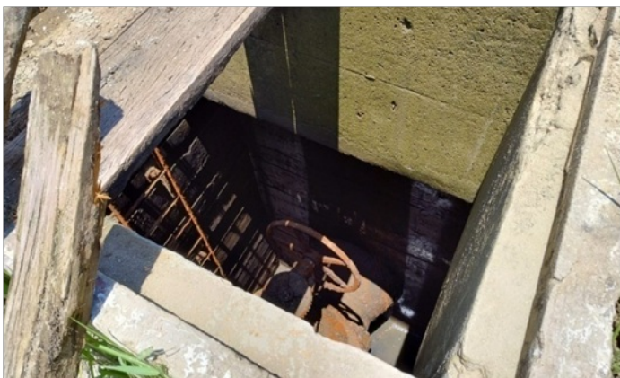
Foto 5: Vista do acesso ao registro e na linha da adutora.
