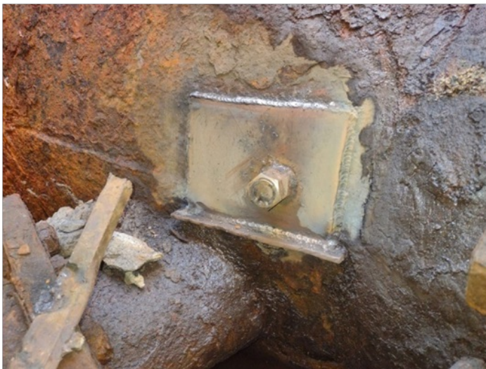
Foto 7: Execução de remendo furo nº “01”(foto fornecida pela CEDAE).
