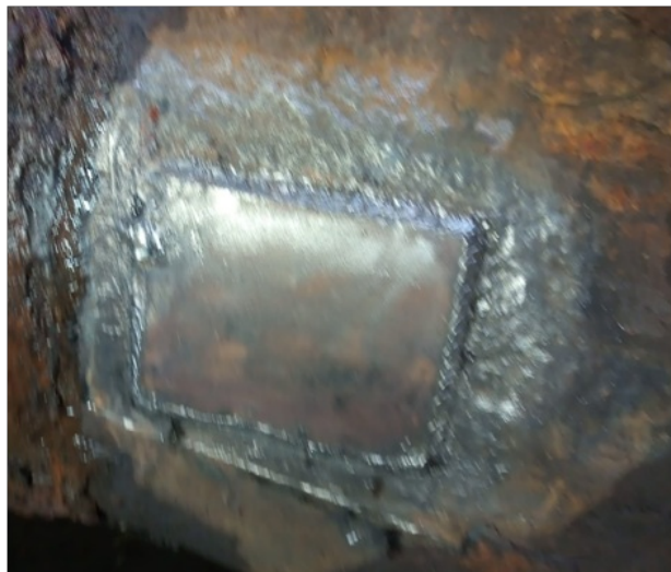
Foto 8: Execução de remendo furo nº “02” (foto fornecida pela CEDAE).
