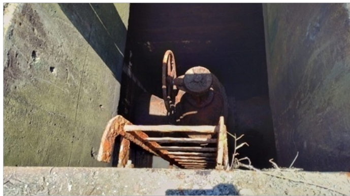
Foto 4: Vista do acesso ao registro e na linha da adutora.
