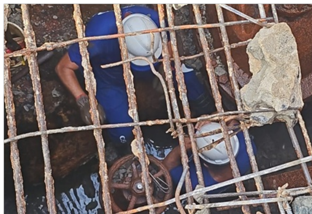
Foto 6: Parte da equipe de manutenção executando os serviços ”(foto fornecida pela CEDAE).
