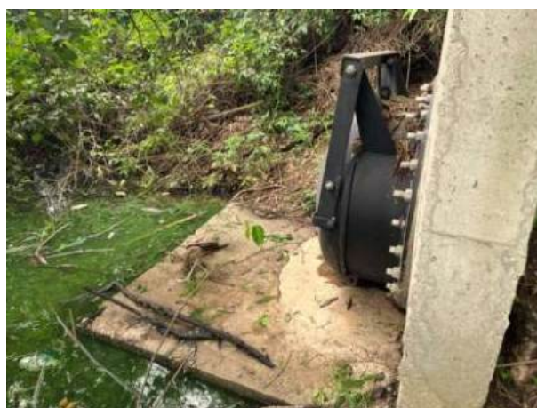
Figura 34: Extravasador da EE Lagoa da Tijuca desligado.
