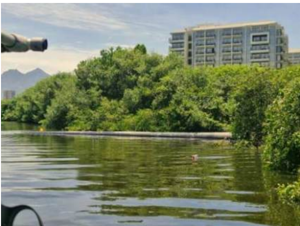
Figura 3: Trecho da tubulação aparente que se desconectou da caixa de transição à jusante.
