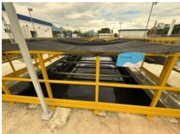
Figura 20: Decantador novo (executado durante as obras do Retrofit) em processo de enchimento, no início da operação.
