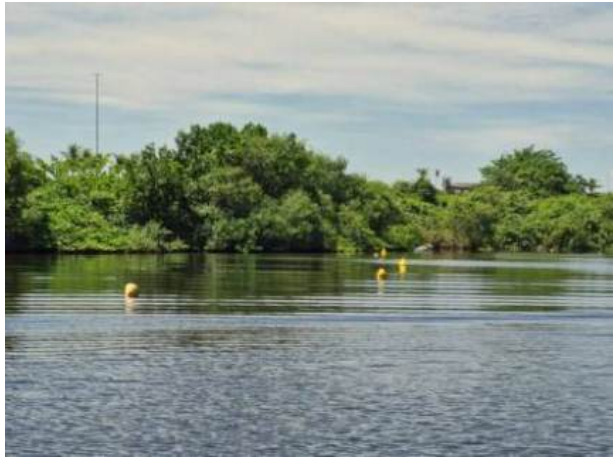
Figura 2: Trecho a jusante da travessia, onde a ponta da tubulação emergiu.
