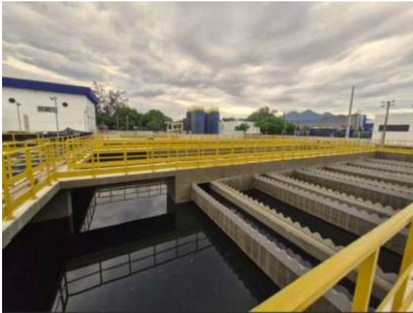
Figura 22: Decantador novo em enchimento, precedendo o início da operação.
