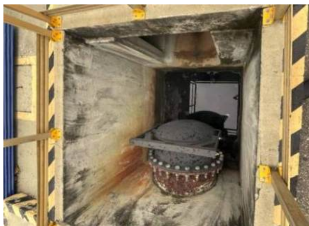
Figura 37: Extravasador da EE Marapendi desligado.
