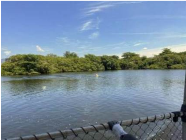
Figura 1: Trecho a montante da travessia, com a tubulação submersa.
