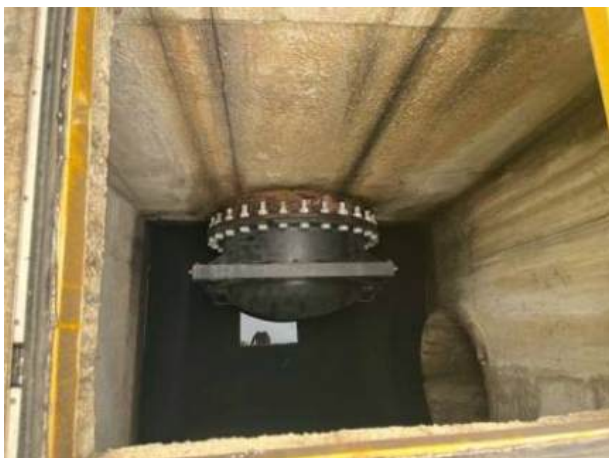
Figura 35: Extravasador da EE Península desligado.
