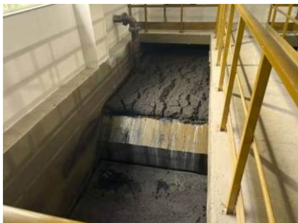
Figura 18: Início da operação da ETE Barra, com o tanque de chegada recebendo contribuição da EEE Marapendi.
