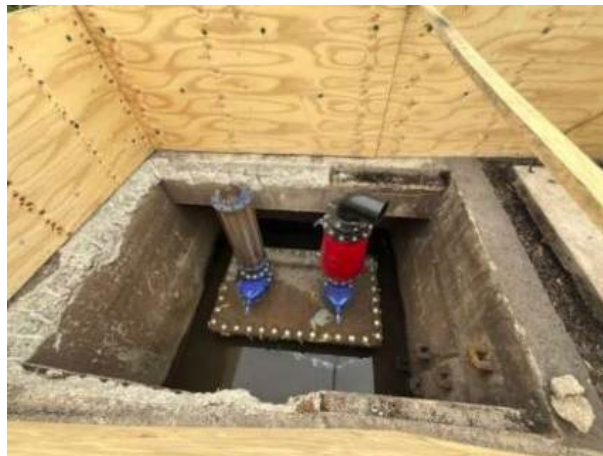
Figura 32: Ventosas recém instaladas na caixa à jusante da travessia na Lagoa de Marapendi, sendo a ventosa da esquerda àquela que estava na caixa de montante (ver vistoria 28/1/26).
