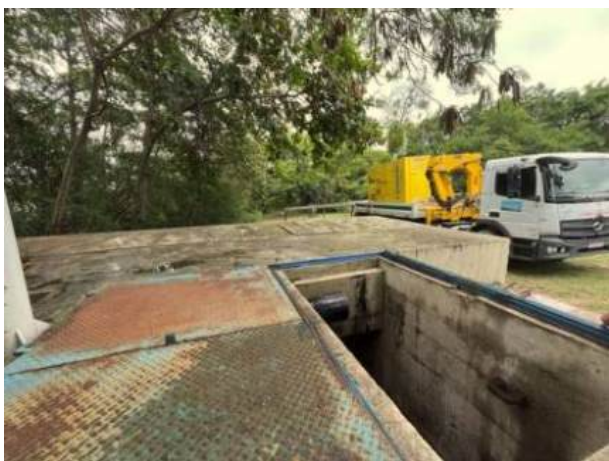
Figura 29: Caixa à montante da travessia na Lagoa de Marapendi.
