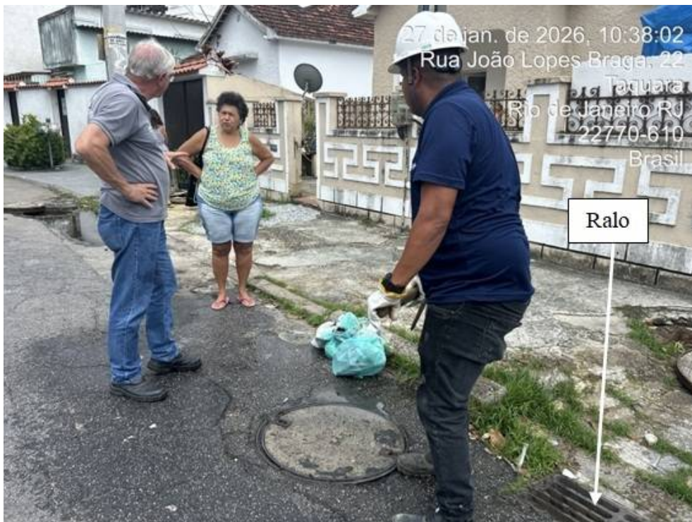
Foto 04 – Ralo da Galeria de Águas Pluviais onde a água do vazamento estava sendo encaminhada
