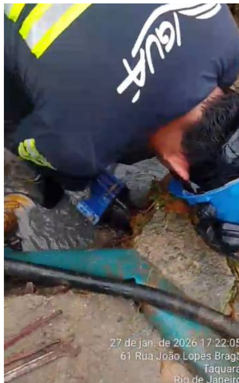
Foto 09 – Reparo do vazamento de água
