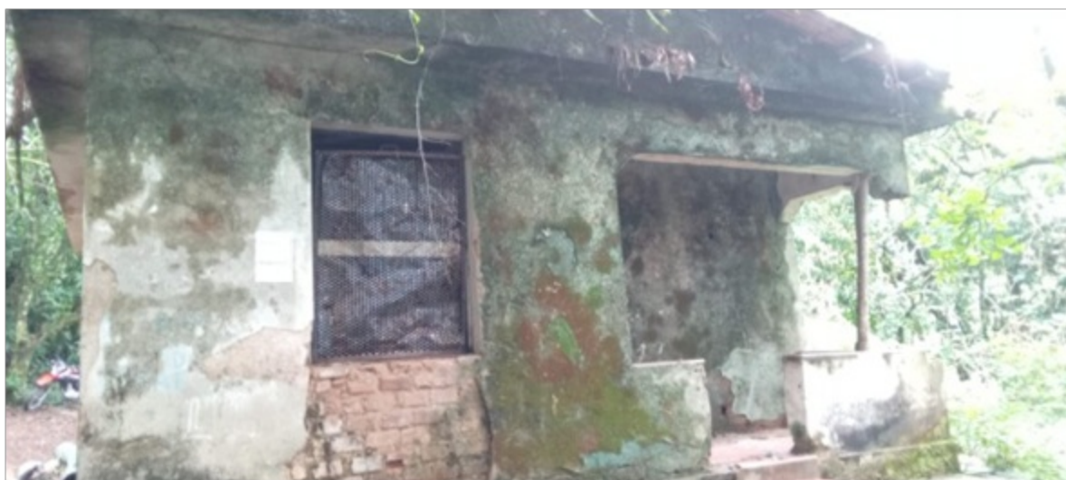
Estrutura na Captação
