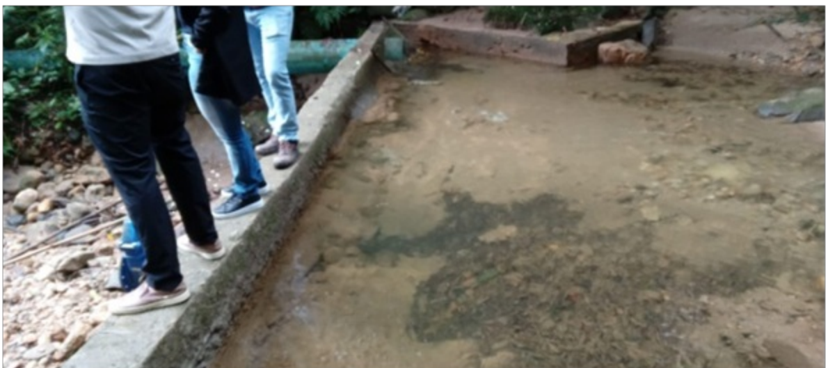
Barragem de regularização de nível
