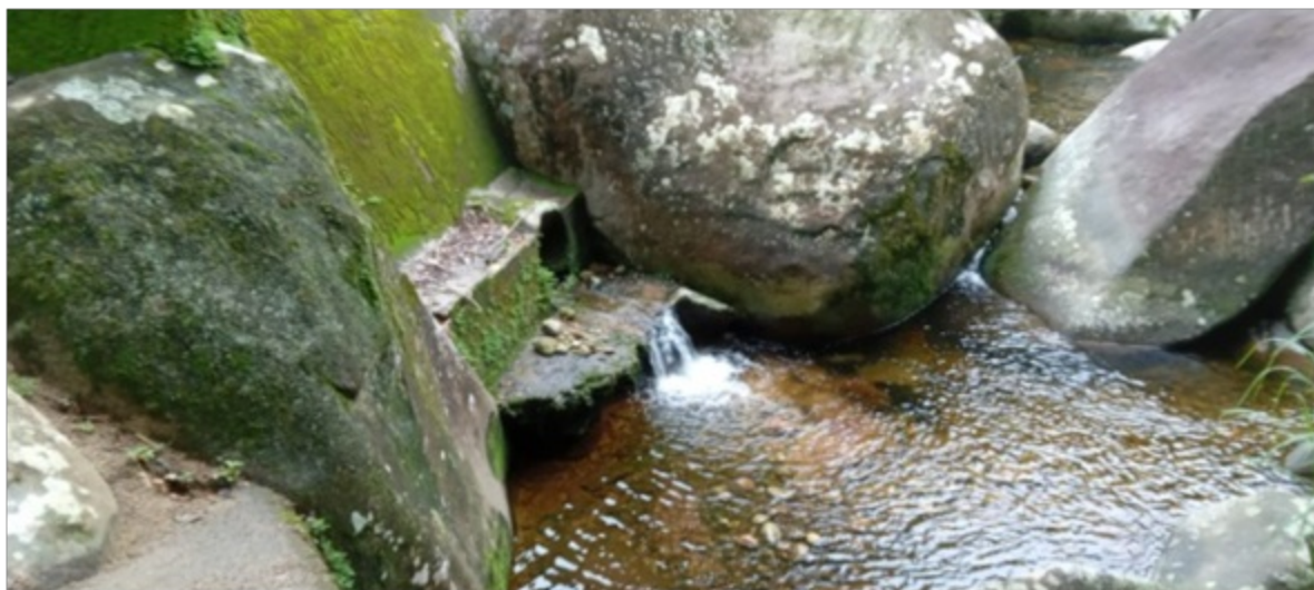
Ponto à jusante da barragem
