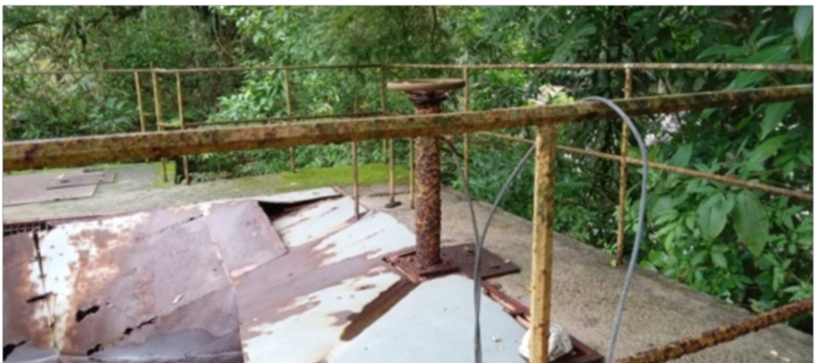
Tanque de Contato
