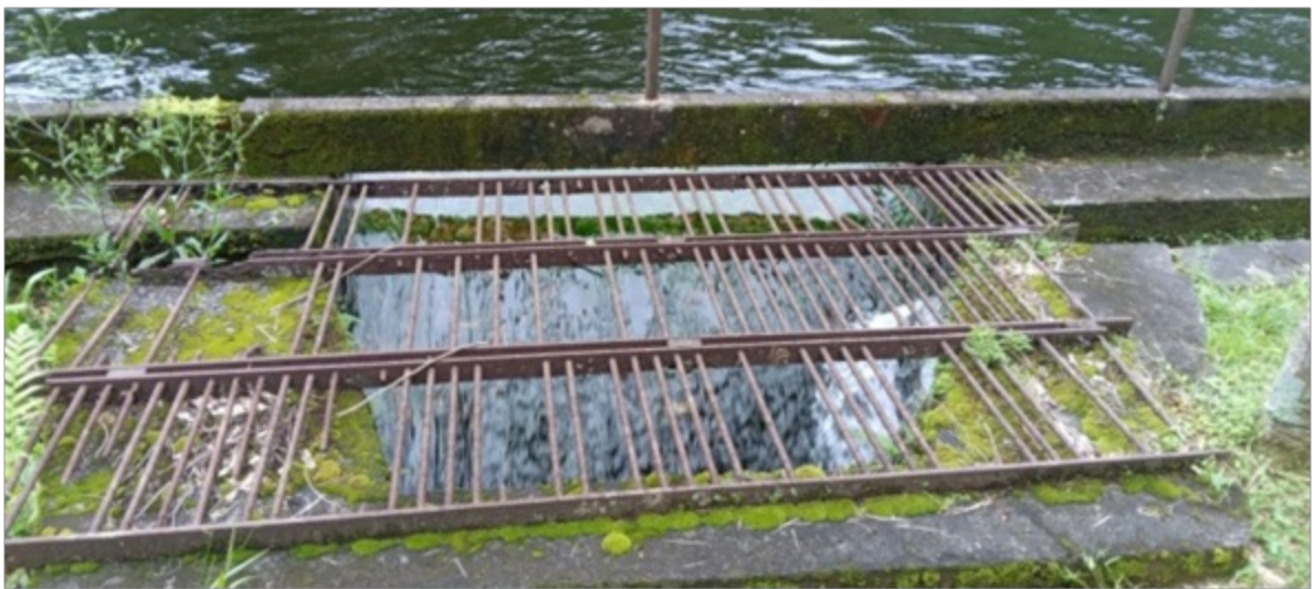
Tomada de água
