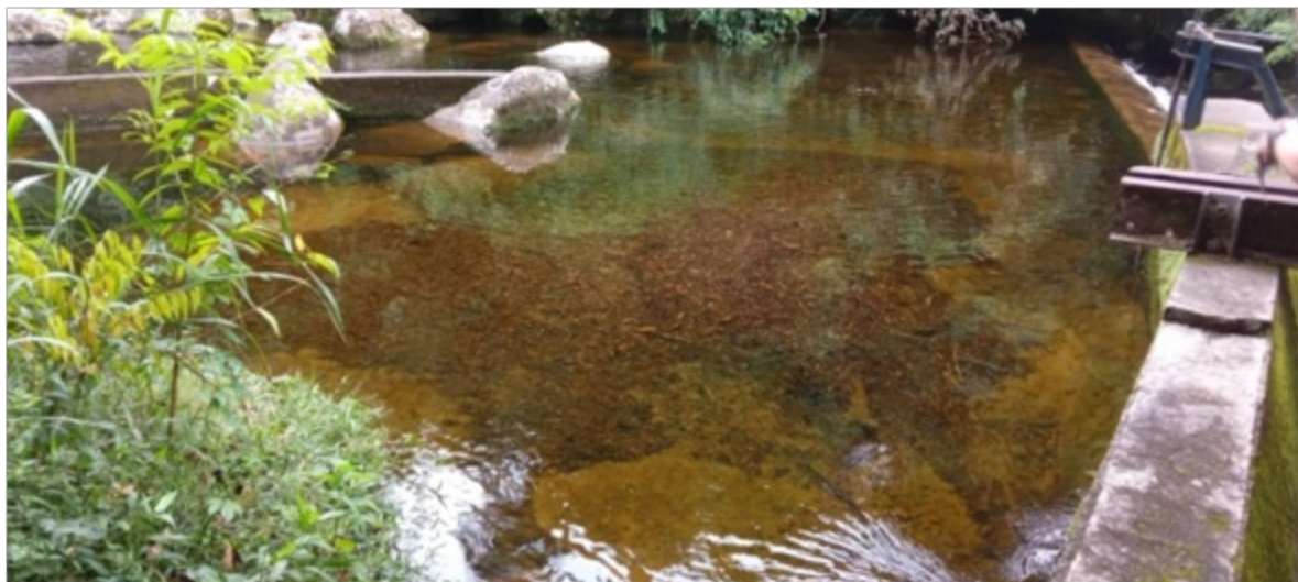
Barragem de regularização de nível
