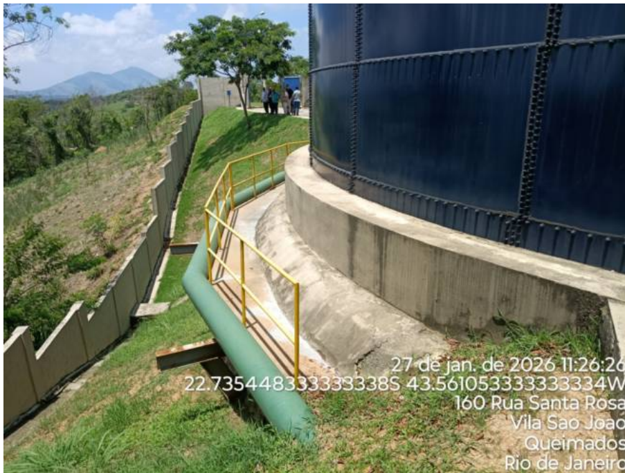
Foto 4: Tubulação de entrada e delimitação da área do ativo.
