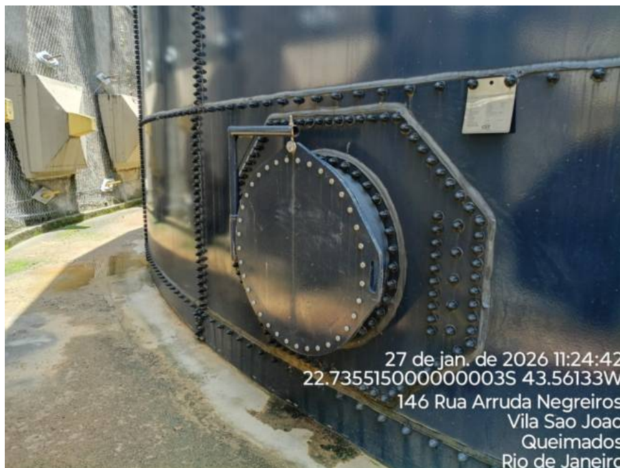
Foto 6: Acesso para inspeção/limpeza.
