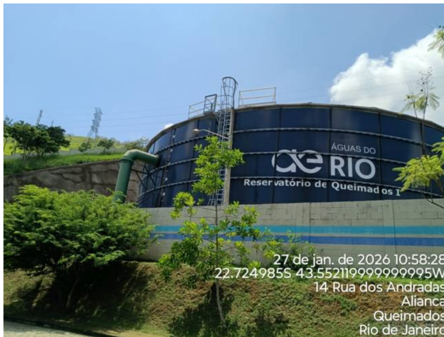
Foto 1: Reservatório Queimados I.
