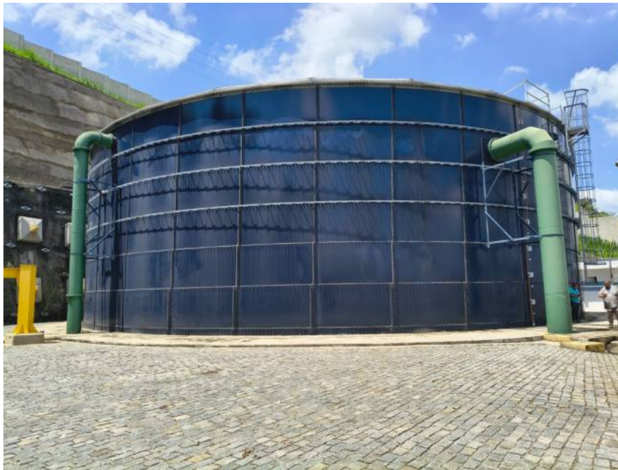
Foto 6: Tubulações de extravasamento e de entrada em boas condições estruturais, bem como escada de acesso disposta adequadamente.
