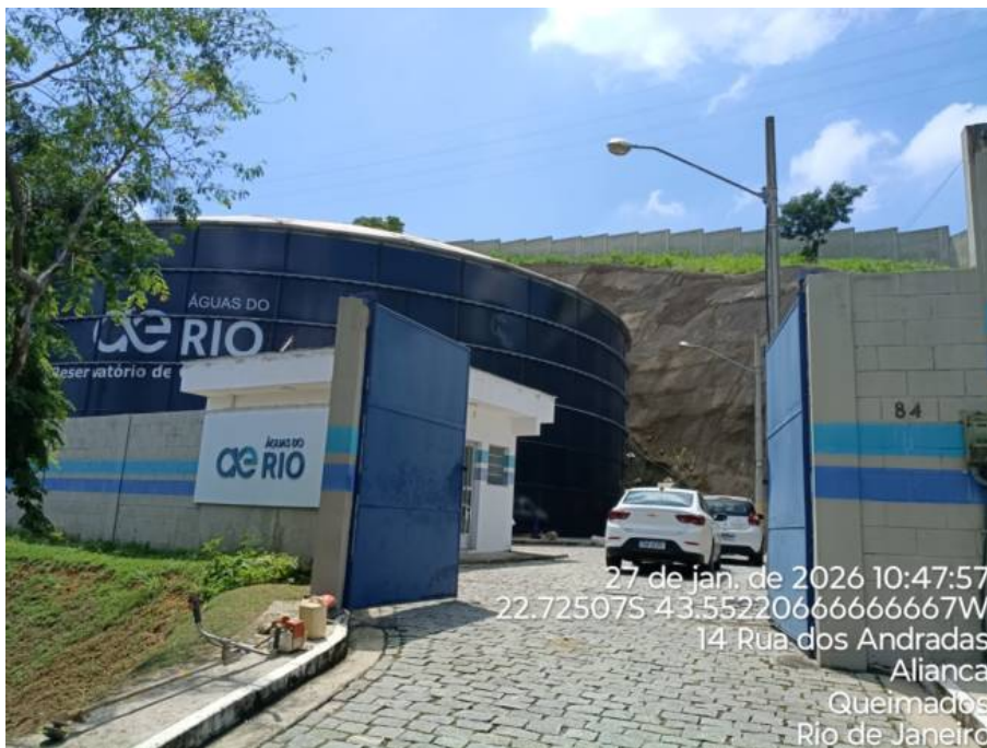
Foto 3: Área de acesso com a devida identificação e delimitação adequada do terreno.
