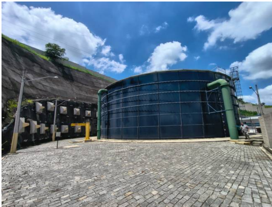
Foto 2: Reservatório com pintura recente e boas condições estruturais. Talude com obra de contenção.
