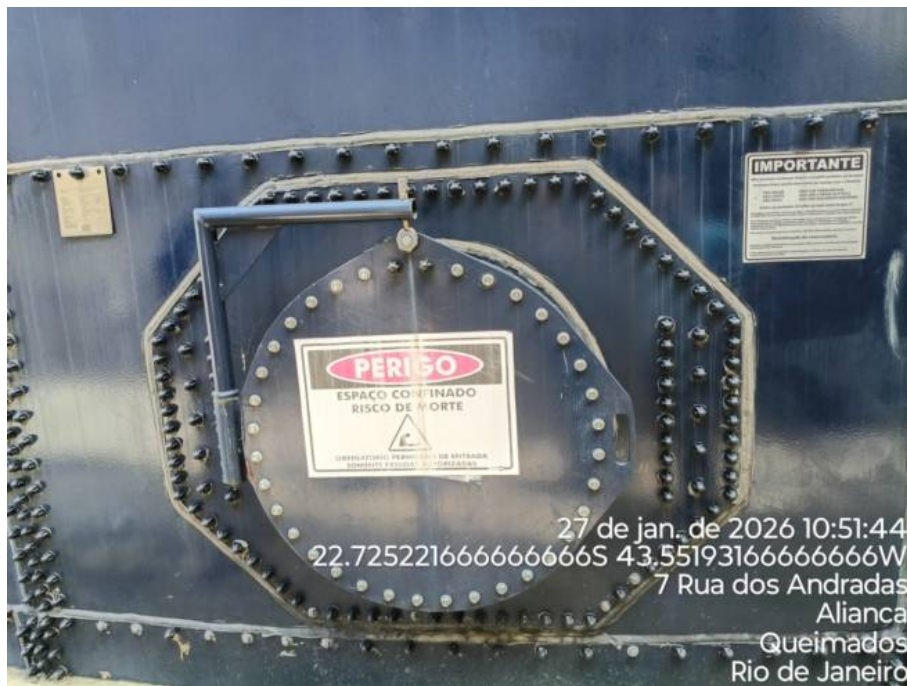
Foto 5: Acesso para inspeção/limpeza.
