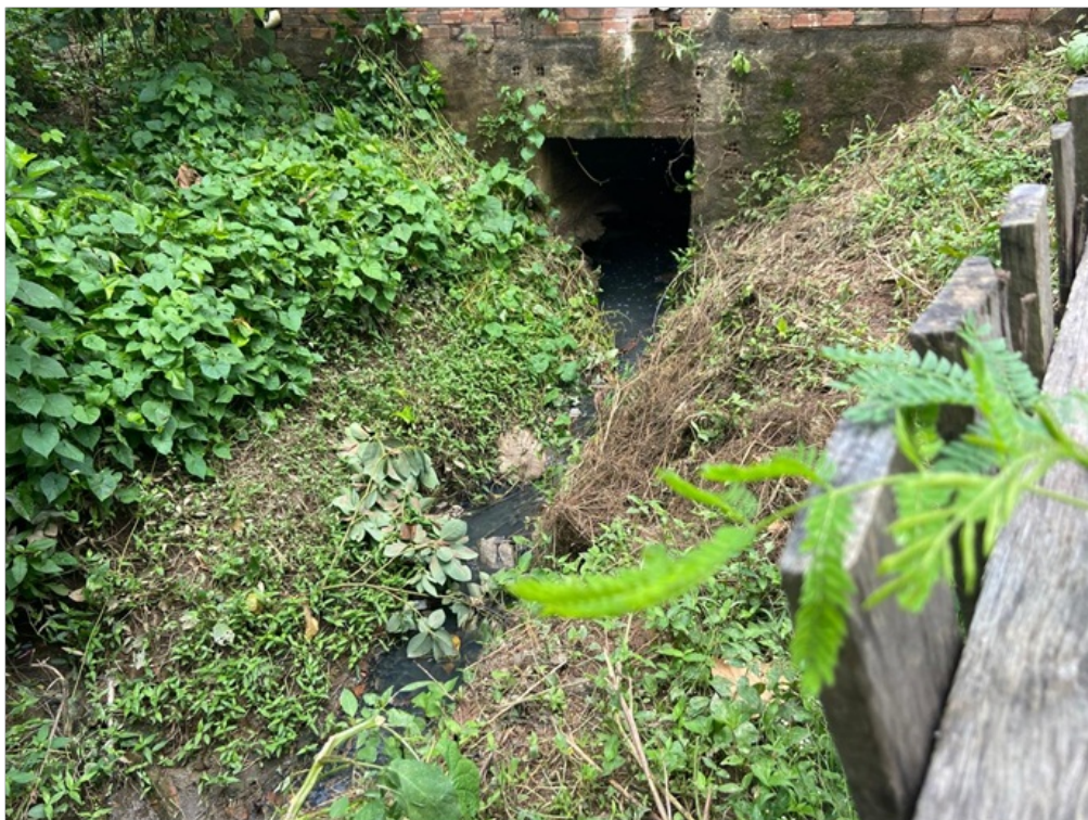
FOTO 02 – Esgoto in natura, chegando através do sistema de drenagem após o muro da residência de nº 161, escoando a céu aberto, em direção ao Rio Paraíba do Sul.
