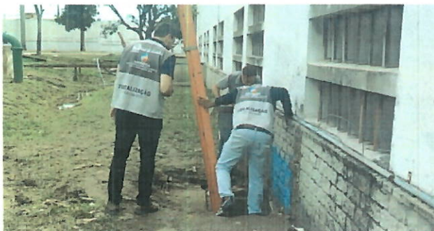
Foto 6 - Inspeção do poço de visita onde se localizava a válvula de fechamento.
