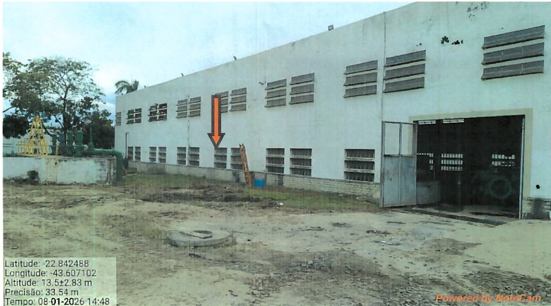
Foto 5 - Prédio onde se localizam os grupos de motobombas Elevatório do Alto Recalque do Guandu – ARG com destaque da localização do poço de visita onde estava instalada a válvula de fechamento. Na ocorrência do refluxo da água, após o rompimento da válvula esta área ficou alagada, com transbordamento pelas janelas e invasão de águas pela porta do imóvel.
