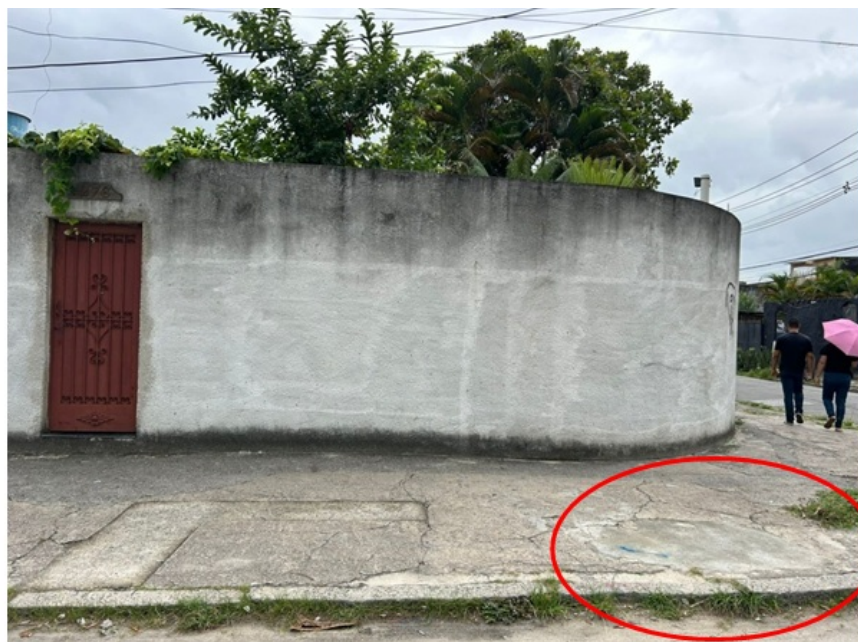
Foto 14 - Vazamento na calçada reparado, nº 276
