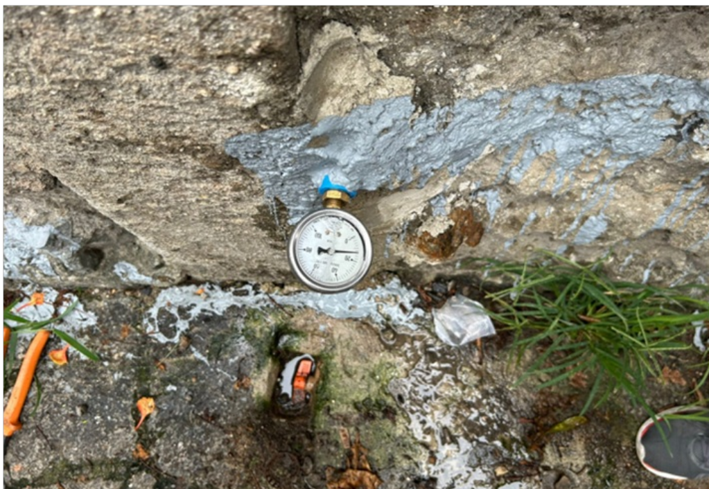
Foto 11 – Pressão manométrica medida de 8 MCA no imóvel nº 190
