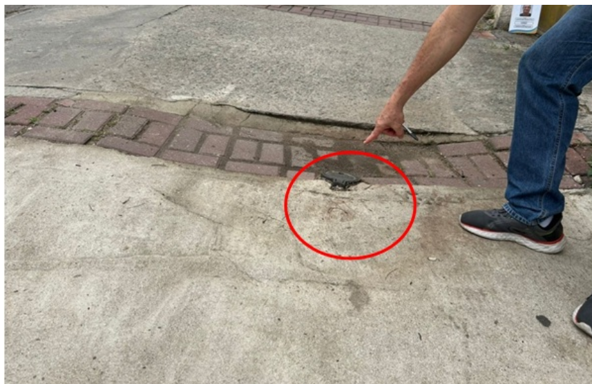
Foto 16 - Substituição de registro DN 150 mm que estava travado com a comporta aberta
