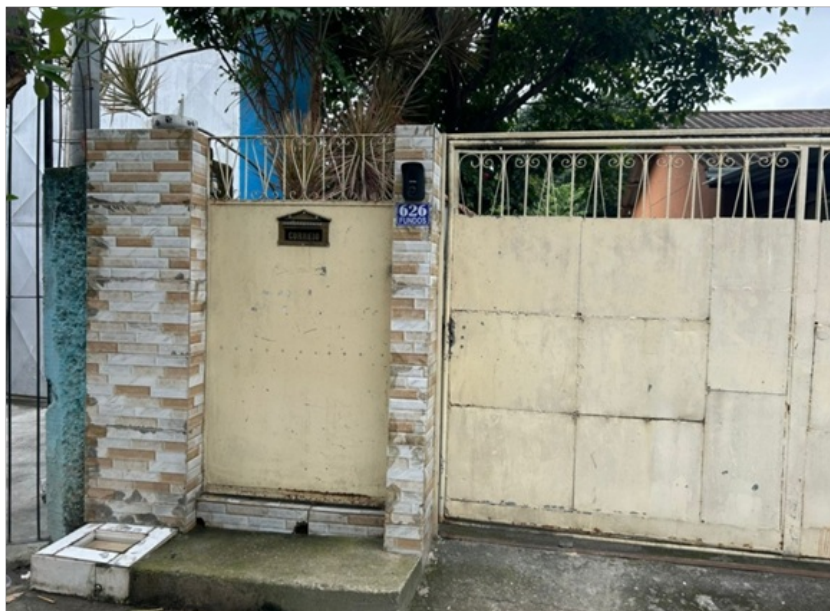
Foto 2 - Imóvel nº 626 (fundos), Rua Albino Paiva
