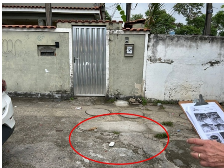
Foto 15 - Vazamento na calçada do imóvel nº 129 reparado
