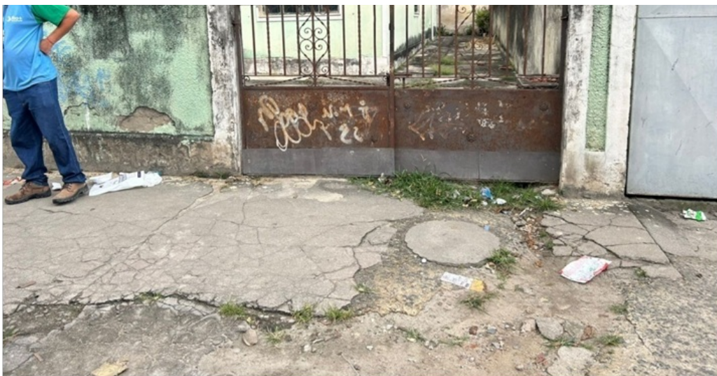
Foto 13 - Troca de ramal danificado, nº 493
