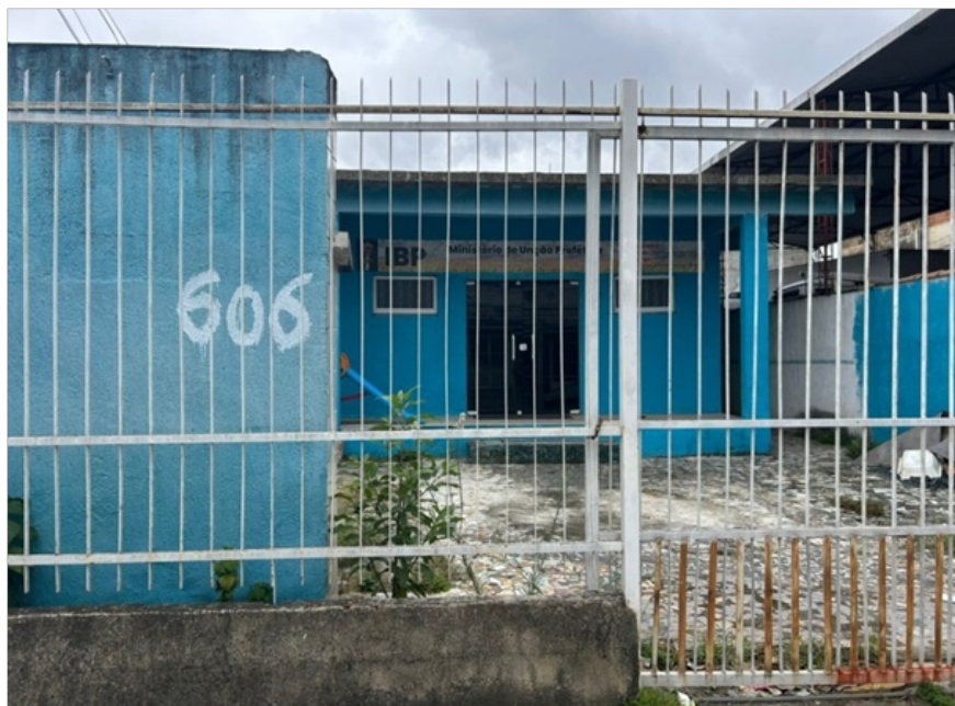
Foto 1 - Imóvel de nº 606 (frente), Rua Albino Paiva - Senador Camará
