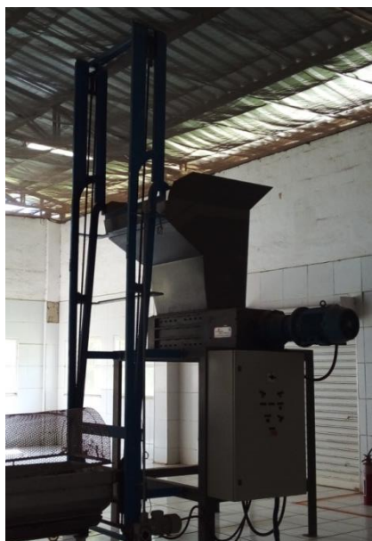
Figura 48: Autoclave disponibilizada para realizar o tratamento de RSS. Inoperante.
