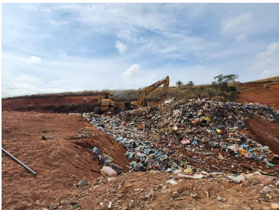
Figura 7: Trator e retroescavadeira em operação
