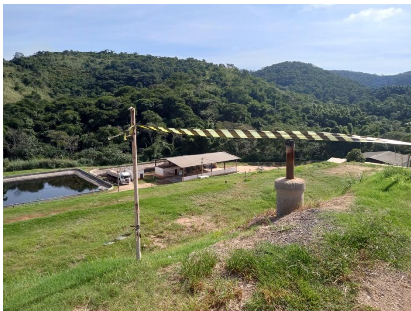
Figura 40: Vista aérea lagoa de chorume e no detalhe, o queimador.
