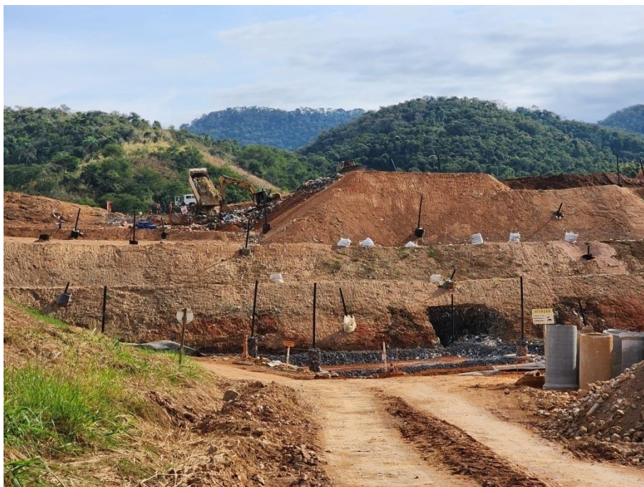
Figura 8: Vista da nova área a ser operada e frente de trabalho ao fundo
