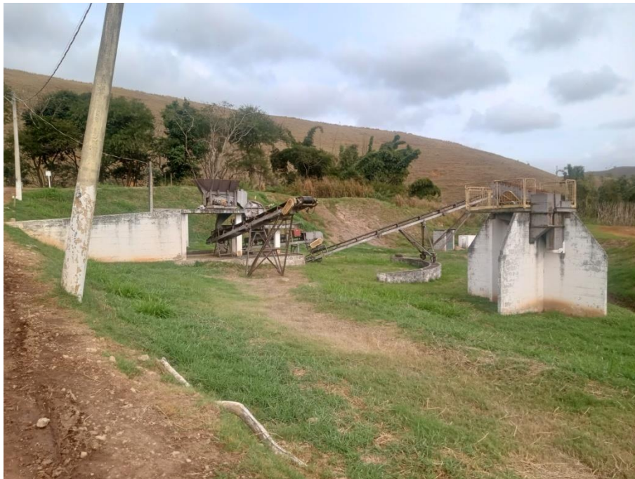
Figura 14: Triturador de resíduos da construção civil. Há um funcionamento muito abaixo do esperado, esporadicamente tem sido posto em operação
