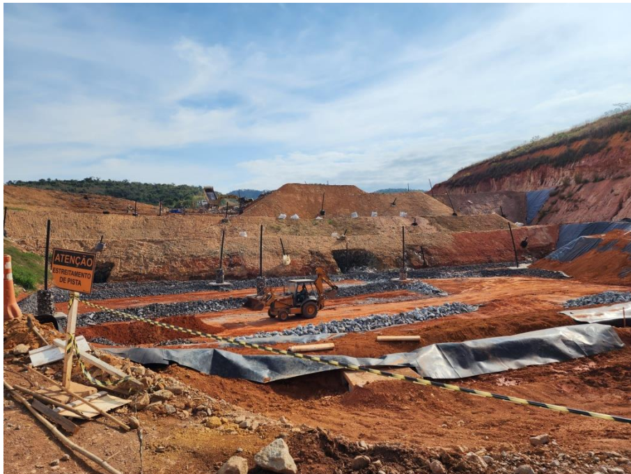
Figura 4: Preparação para início de nova célula
