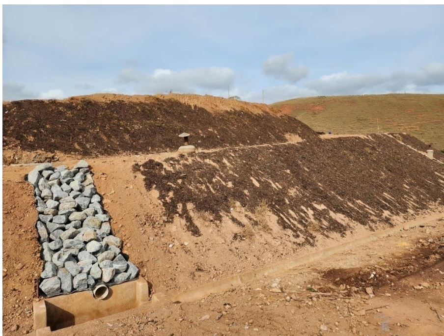
Figura 10: Células com cobertura oriunda da compostagem da massa verde
