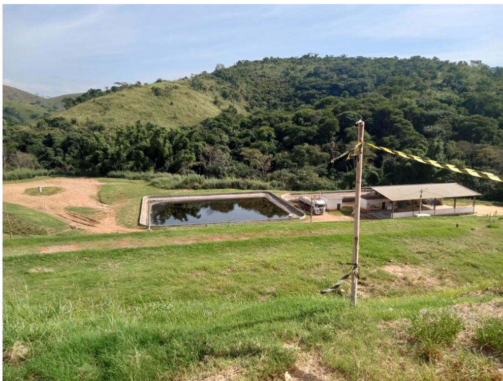
Figura 39: Vista panorâmica da lagoa de armazenamento de chorume no momento da coleta pelo caminhão tanque
