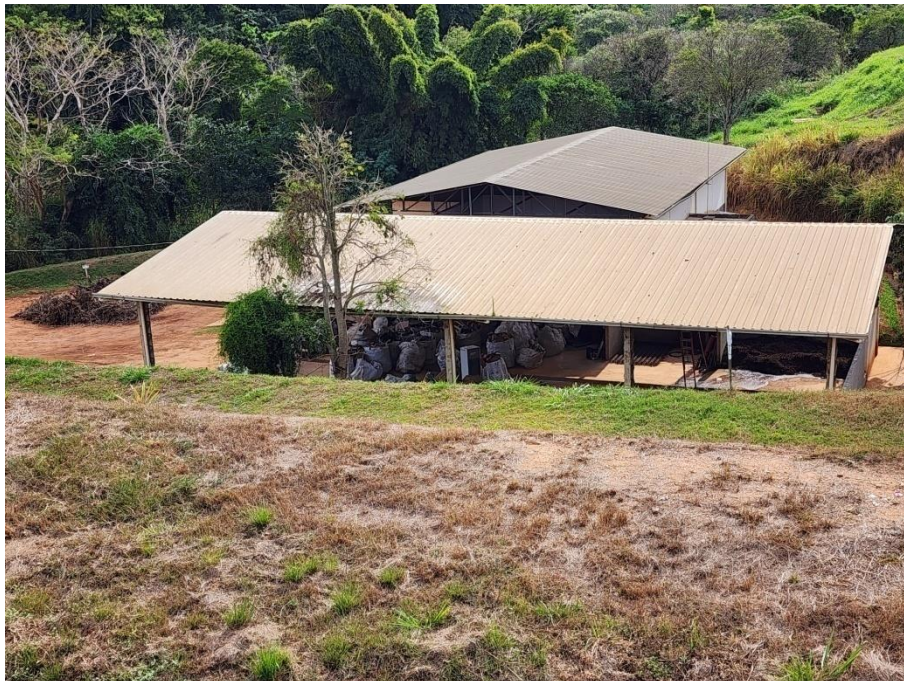
Figura 15: Galpão de armazenamento e triagem de coleta seletiva
