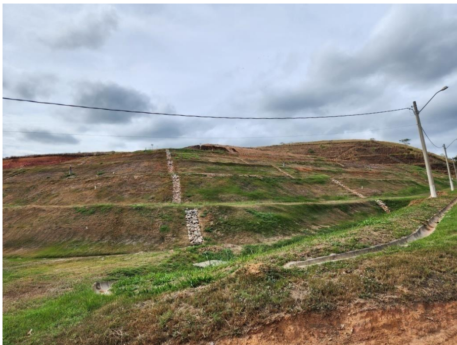
Figura 9: Vista de camadas concluídas e com cobertura vegetal
