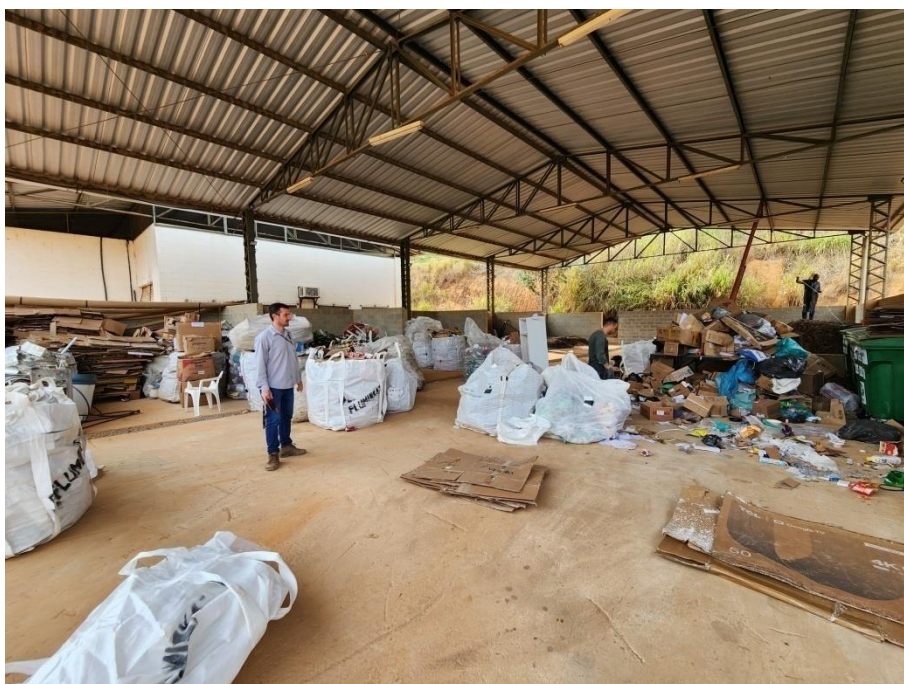
Figura 17: Galpão de coleta seletiva
