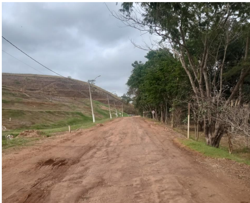
Figura 2: Estrada de acesso interno do aterro
