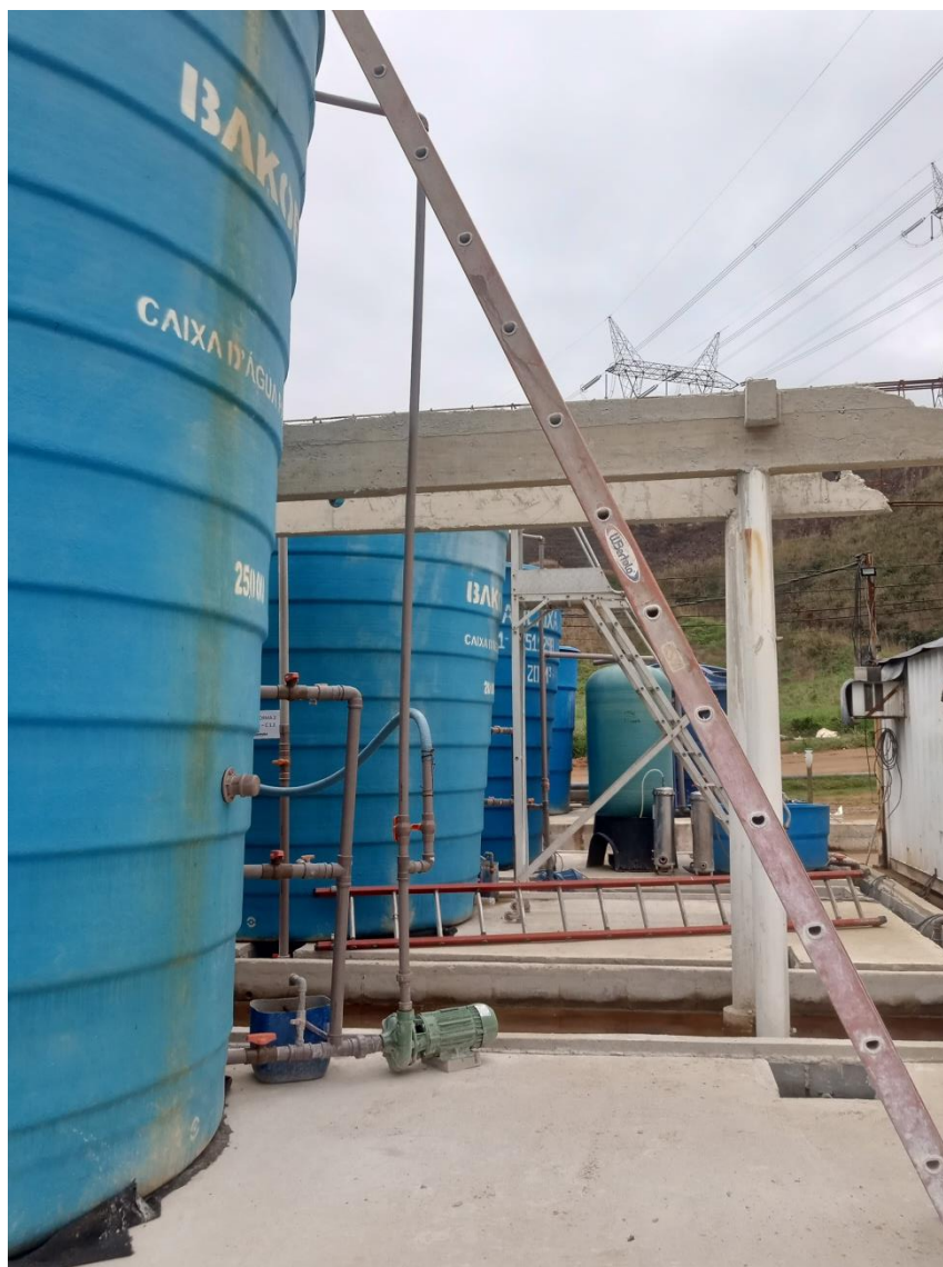
Figura 14: Ampliação e melhorias do local de assentamento dos tanques de água pós tratamento .
