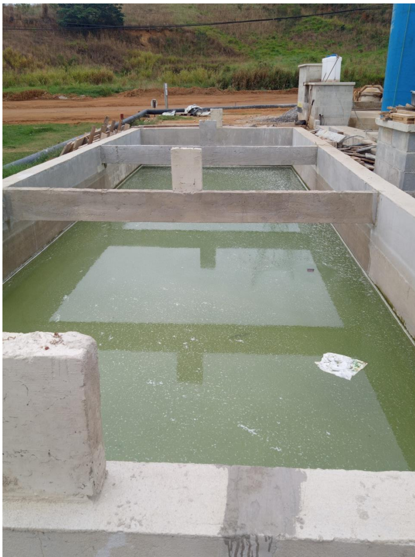
Figura 15: Obra de assentamento para os novos tanques encontra-se em fase de testes.
