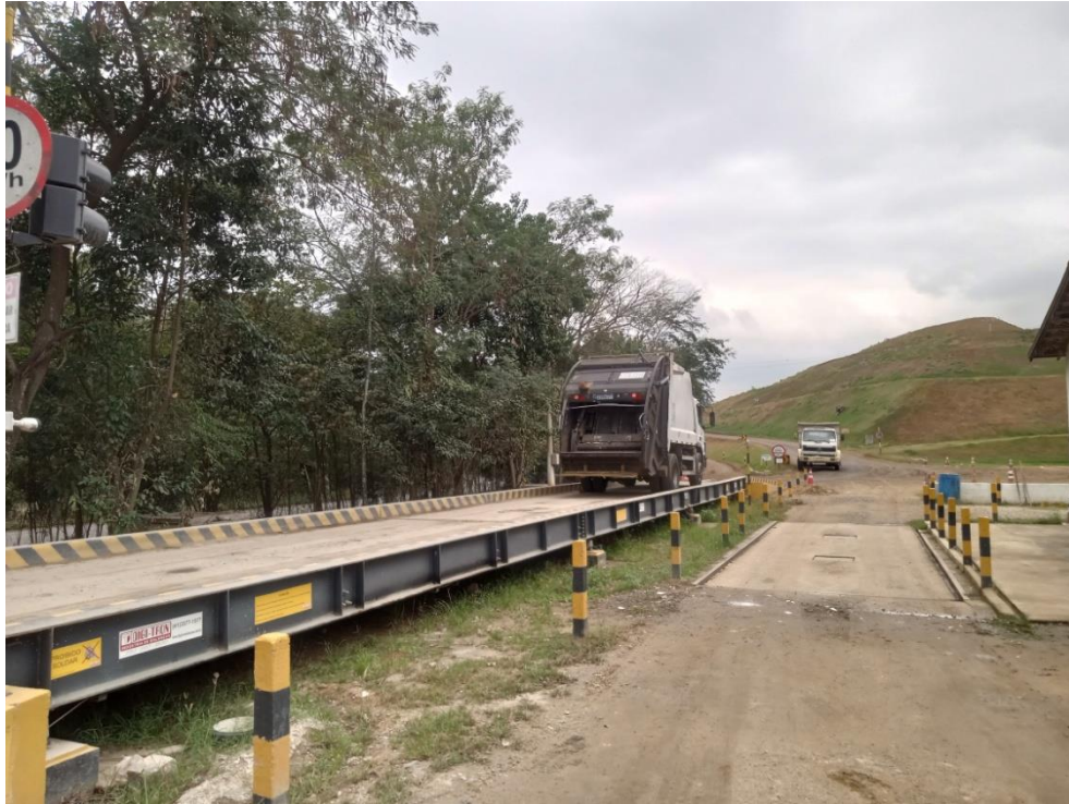
Figura 2: Vista da entrada e balança do CTDR Paracambi.
