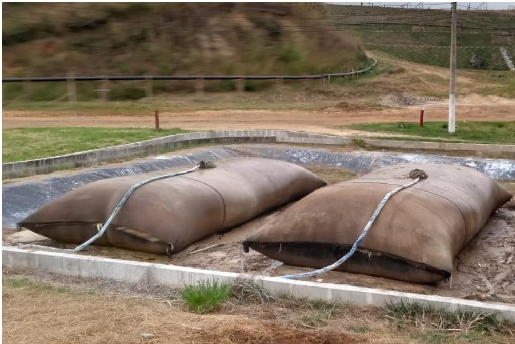
Figura 11: BAGS de armazenagem e secagem de lodo.
