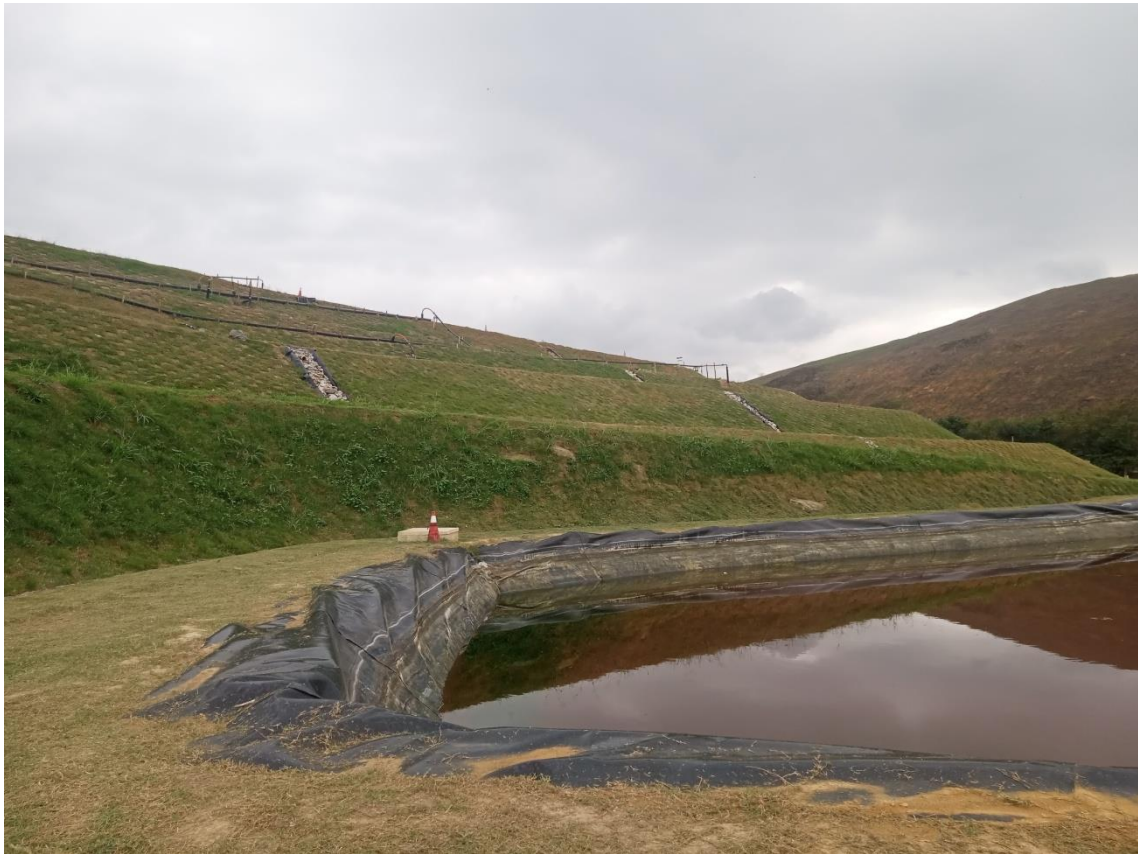
Figura 9 : Nova lagoa de recebimento de chorume já em funcionamento,ao fundo o talude com vegetação recomposta.
