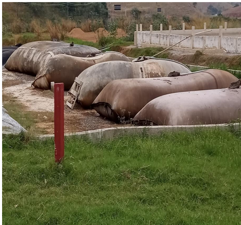
Figura 12: BAGS de armazenagem e secagem de lodo.
