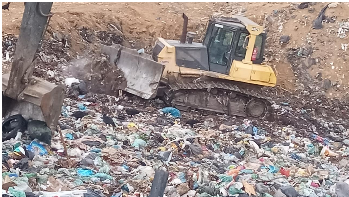
Figura 3: Frente de trabalho - Compactação e cobertura dos resíduos
