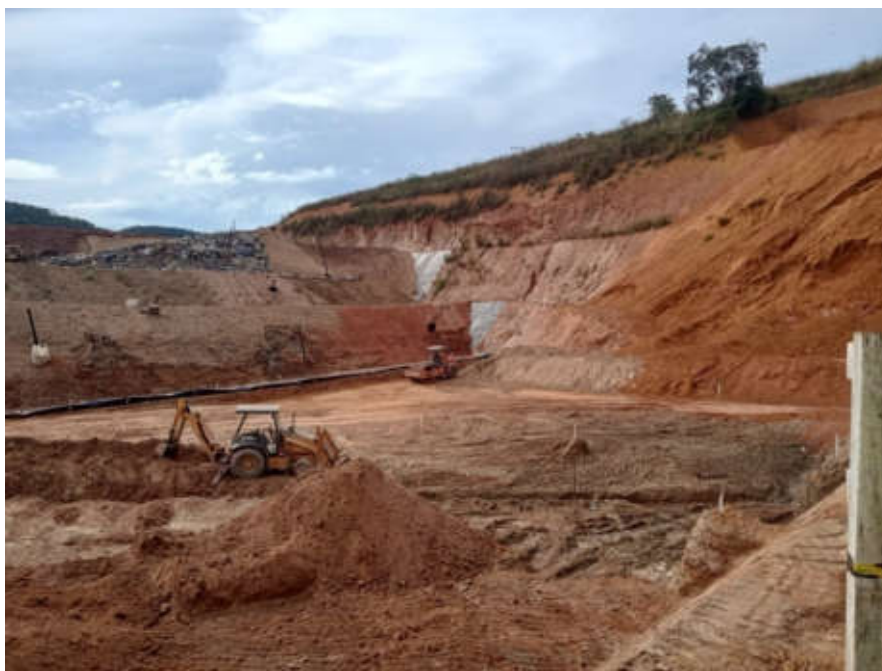
Figura 25: Preparação de nova célula com a frente de trabalho atual ao fundo
