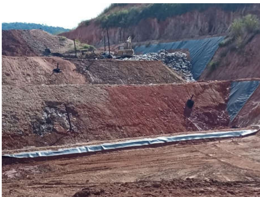
Figura 20: Frente de trabalho. Equipamento compactando resíduos
