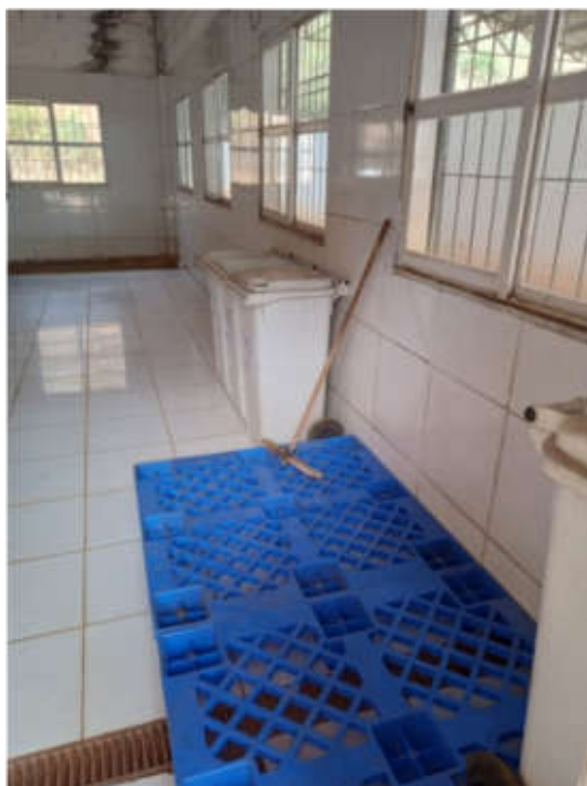
Figura 47: Palet destinado a estocagem de perfurocortantes. Os perfurocortantes haviam sido recolhidos antes da nossa chegada
