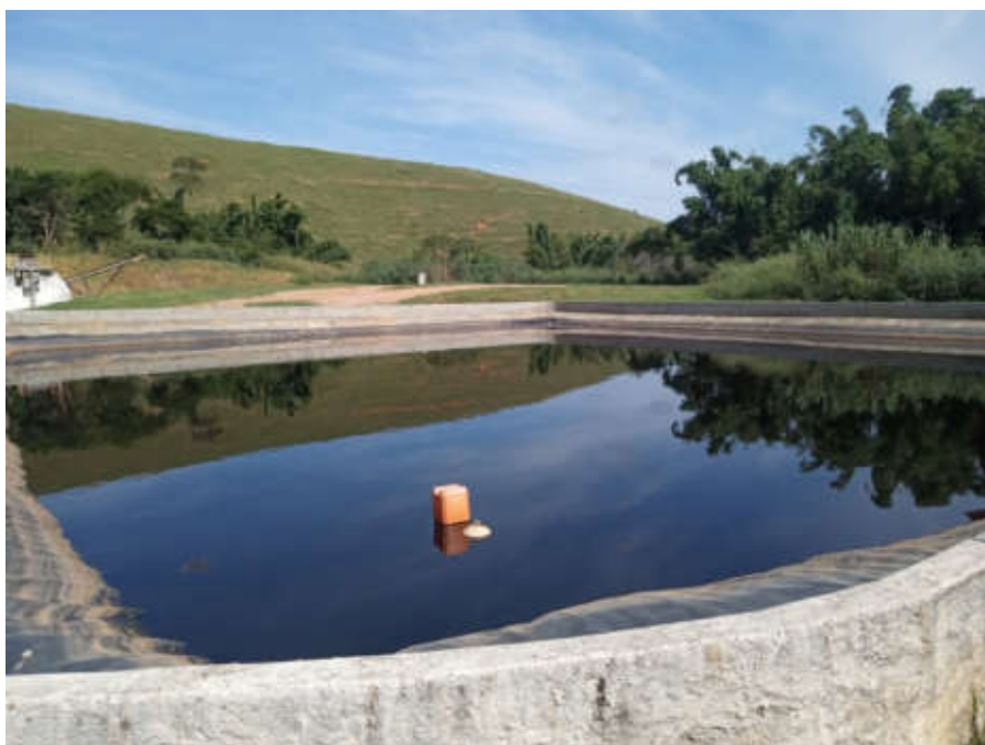
Figura 35: Lagoa de recebimento e armazenagem de chorume.
