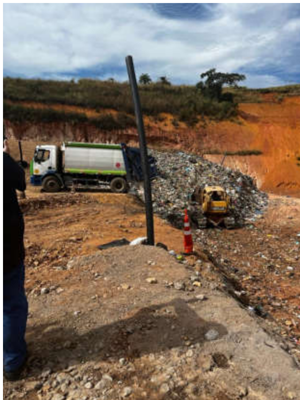
Figura 30: Frente de trabalho . Detalhe Caminhão descarregando
