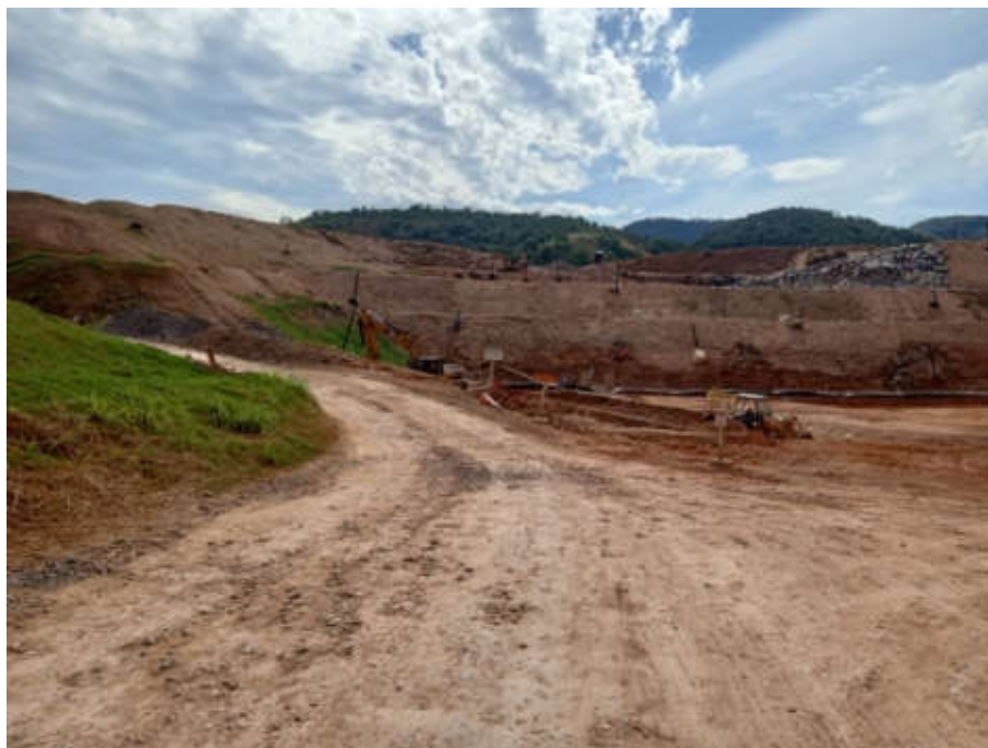
Figura 23: Preparação de nova célula
