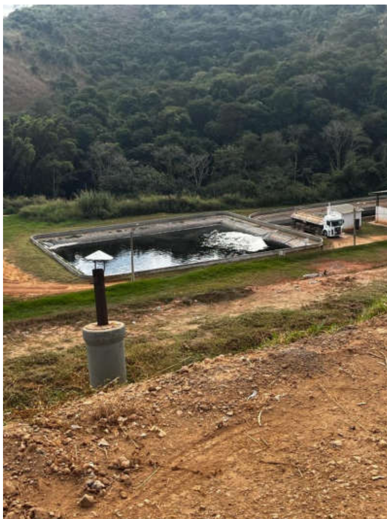
Figura 41: Vista Aérea das Lagoas de Chorume
