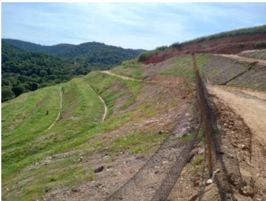
Figura 17: Recomposição vegetal do talude
