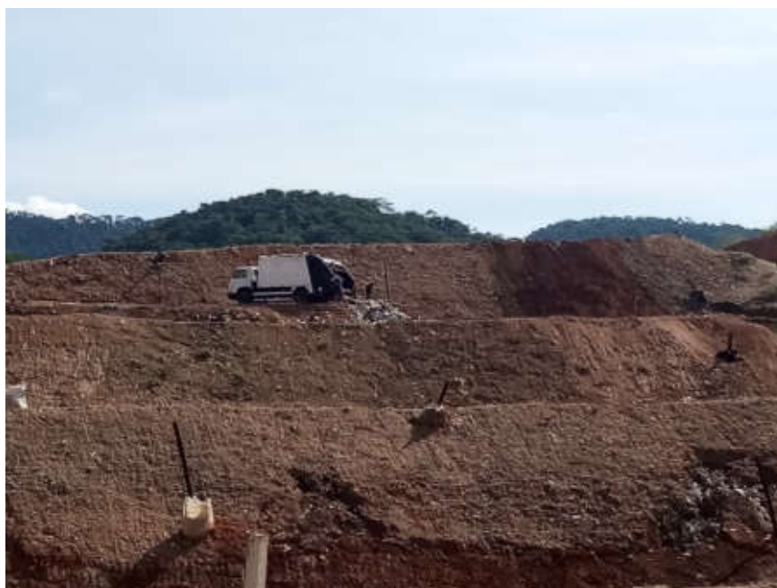
Figura 19: Frente de trabalho. Caminhão descarregando.
