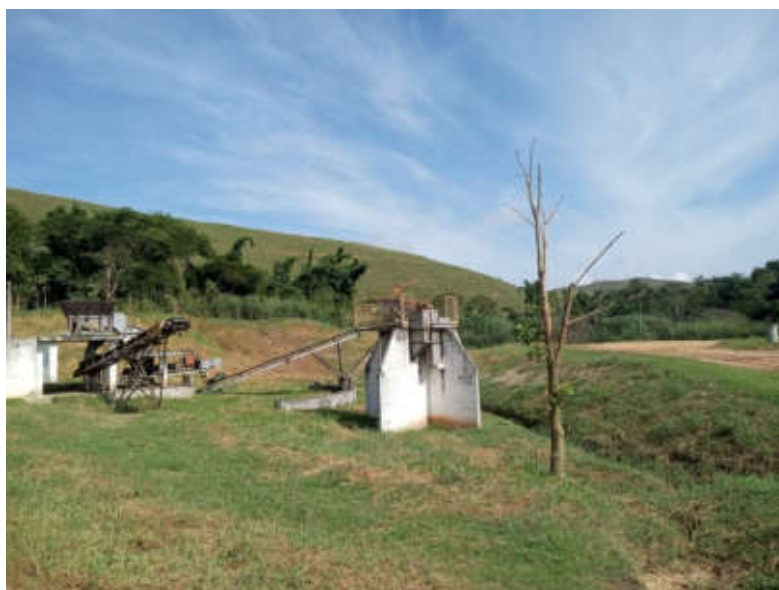
Figura 51: Triturador de resíduos da construção civil. Há um funcionamento muito abaixo do esperado ,esporadicamente tem sido posto em operação
