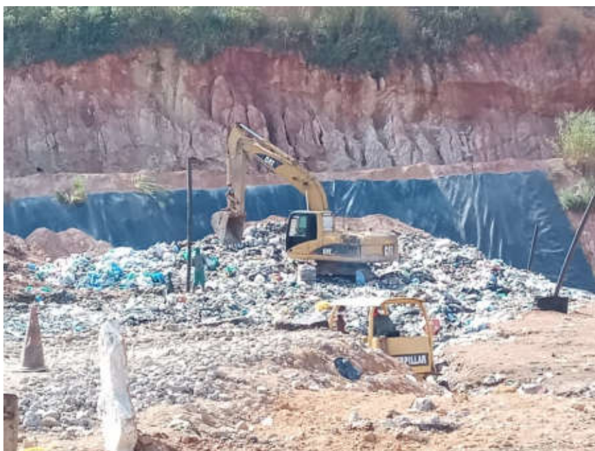
Figura 21: Frente de trabalho. Equipamento compactando resíduos e visão da Geo membrana ao fundo
