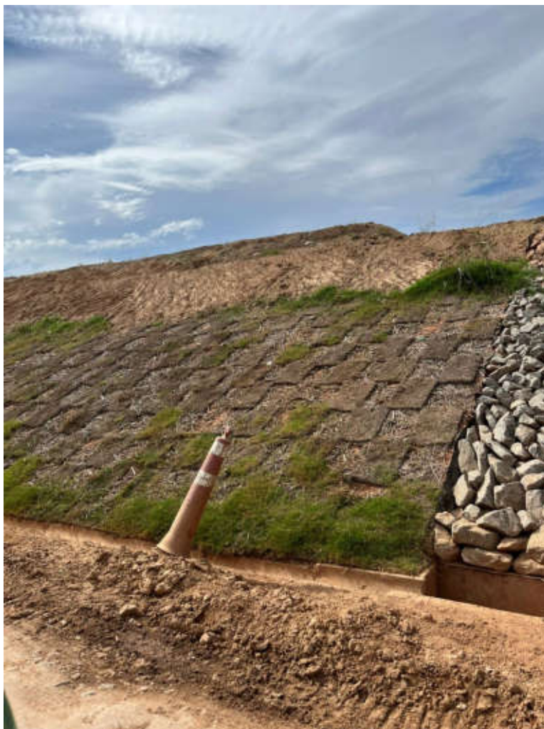
Figura 34: Talude e Drenagem Com Cobertura Vegetal
