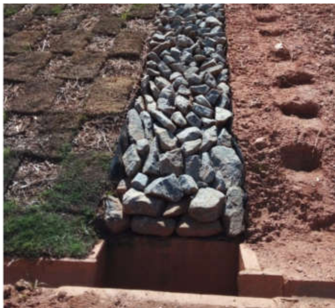
Figura 15: Drenagem do talude
