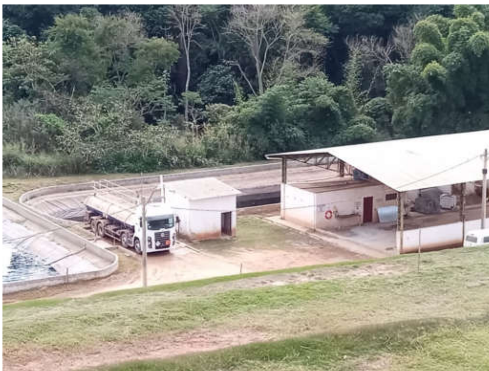
Figura 43: Vista Aérea Lagoas de Chorume
