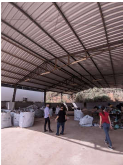
Figura 59: Triagem Galpão De Reciclados
