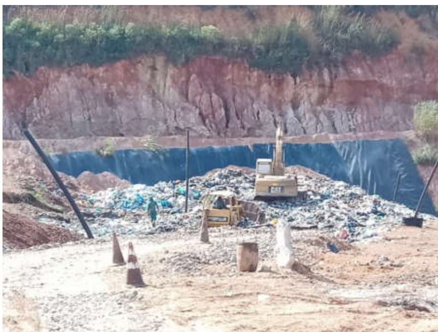
Figura 22: Frente de trabalho. Equipamento compactando resíduos e visão da Geo membrana ao fundo
