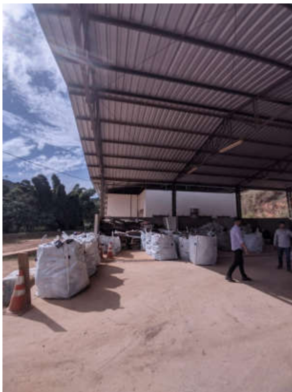
Figura 60: Triagem Galpão De Reciclados
