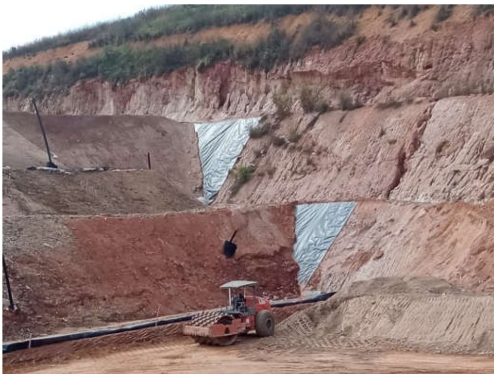
Figura 26: Preparação de nova célula. Detalhe da Geo membrana ao fundo
