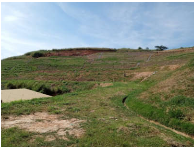
Figura 16: Recomposição vegetal do talude
