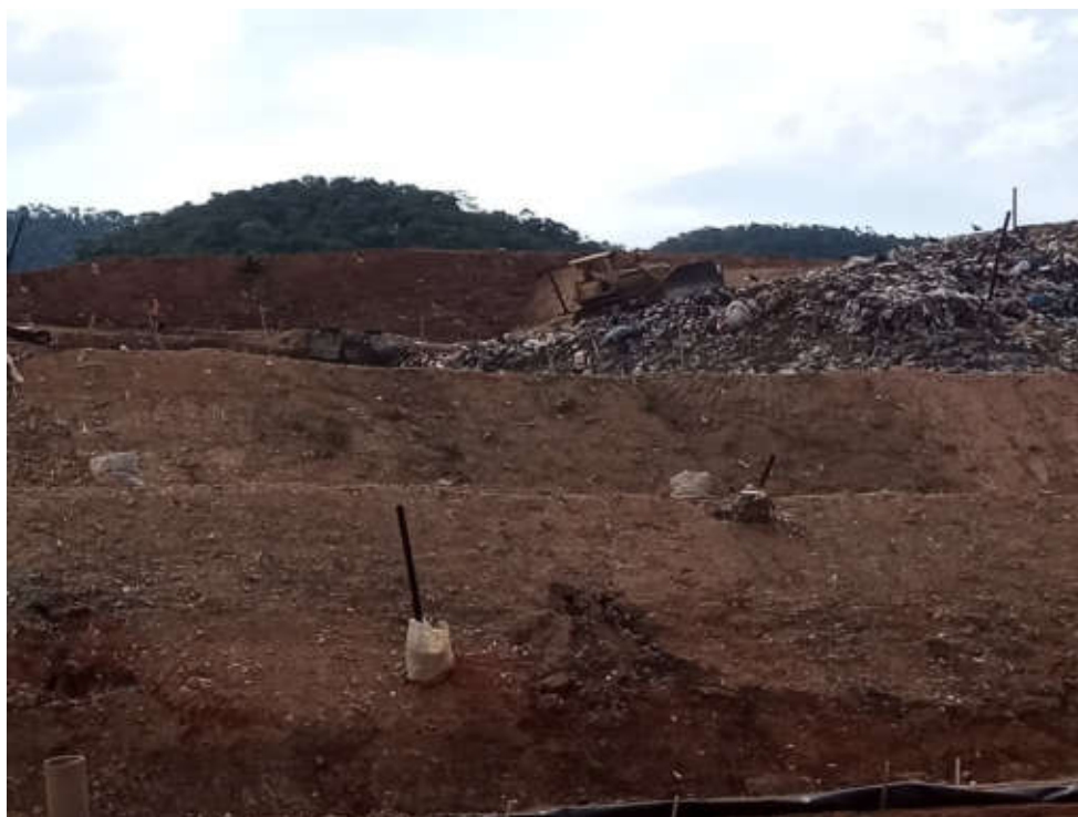
Figura 27: Detalhe Frente de trabalho
