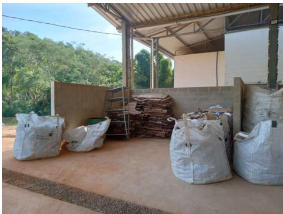
Figura 56: Unidade de triagem da coleta seletiva. Material plástico e papelão já separado e armazenado
