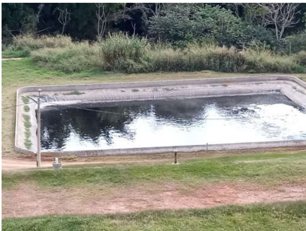
Figura 42: Vista Aérea Lagoas de Chorume
