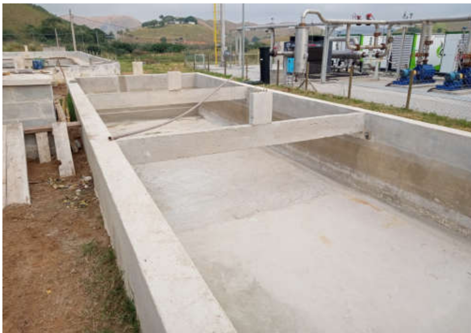
Figura 20: Obra de assentamento para os novos tanques encontra-se em fase de testes.
