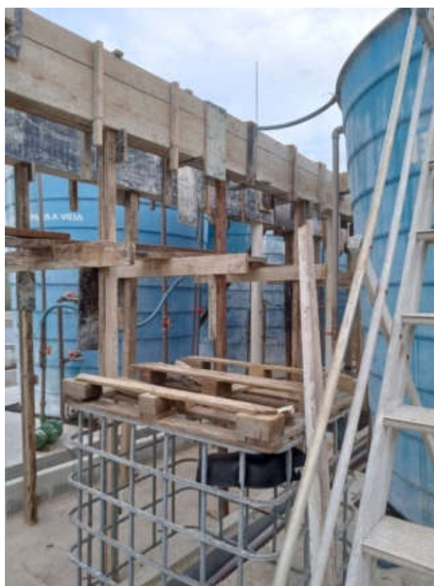
Figura 19: Ampliação e melhorias do local de assentamento dos tanques de água pós tratamento .
