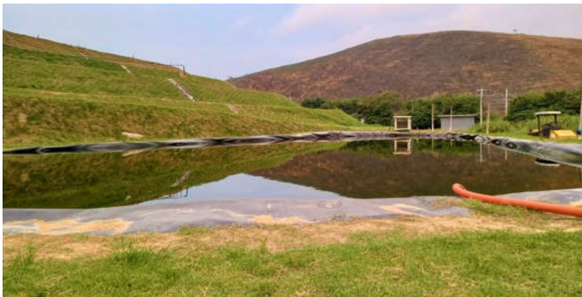
Figura 13 : Nova lagoa de recebimento de chorume já em funcionamento. Talude com vegetação recomposta.
