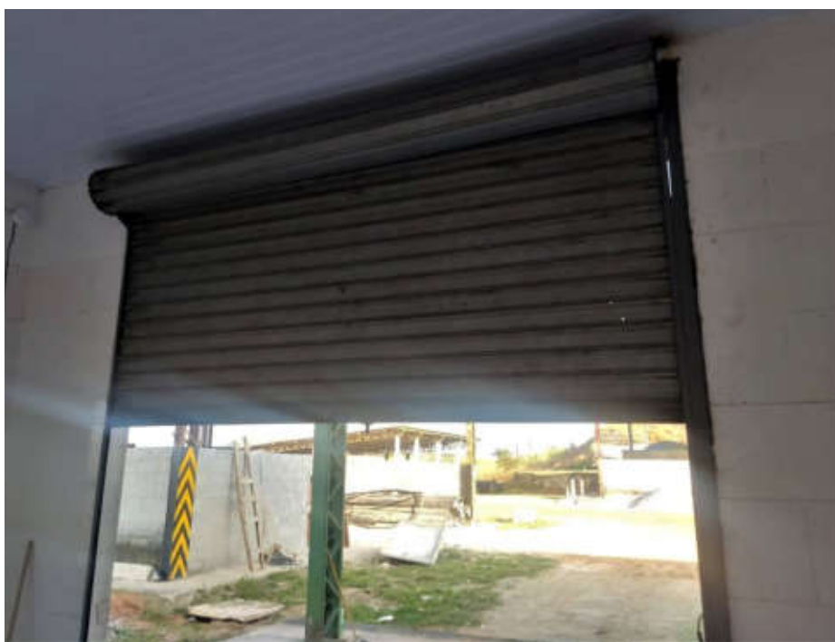
Figura 22: A porta provisória do galpão de RSS já foi substituída pela de ferro
