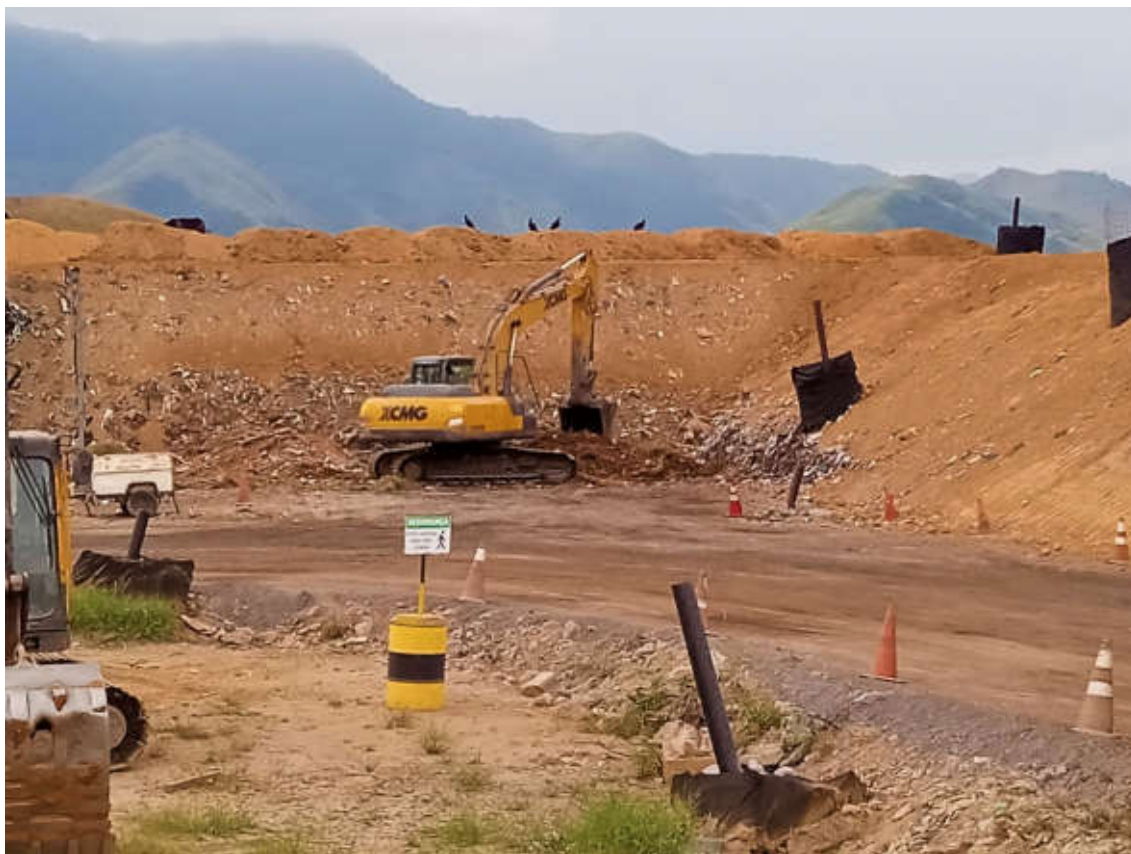
Figura 6: Frente de trabalho – Cobertura dos Resíduos
