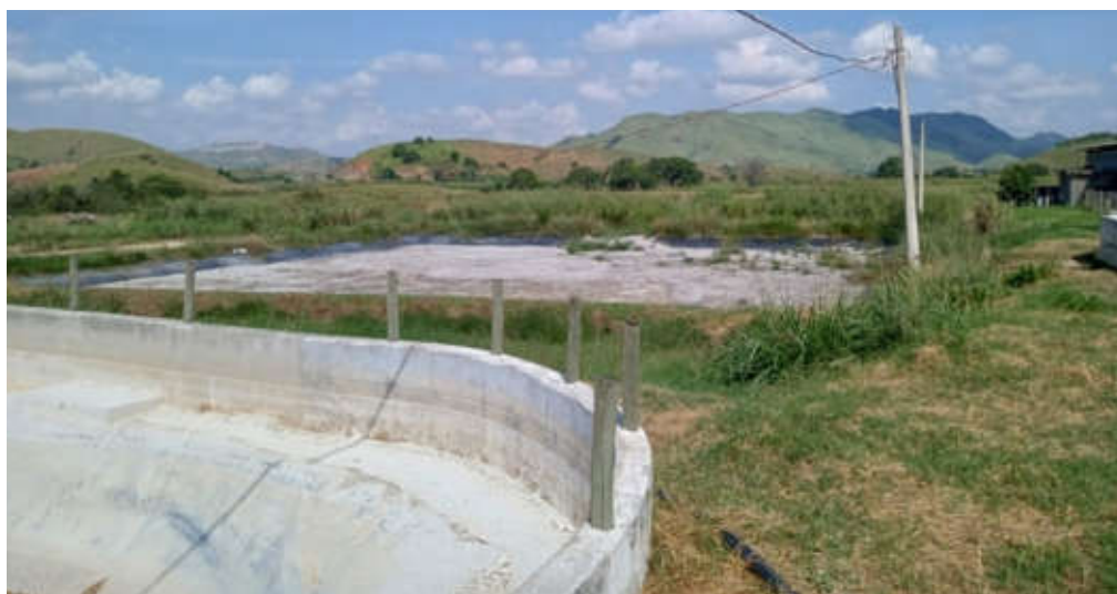
Figura 18 : Construção de uma nova lagoa para recebimento de chorume.
