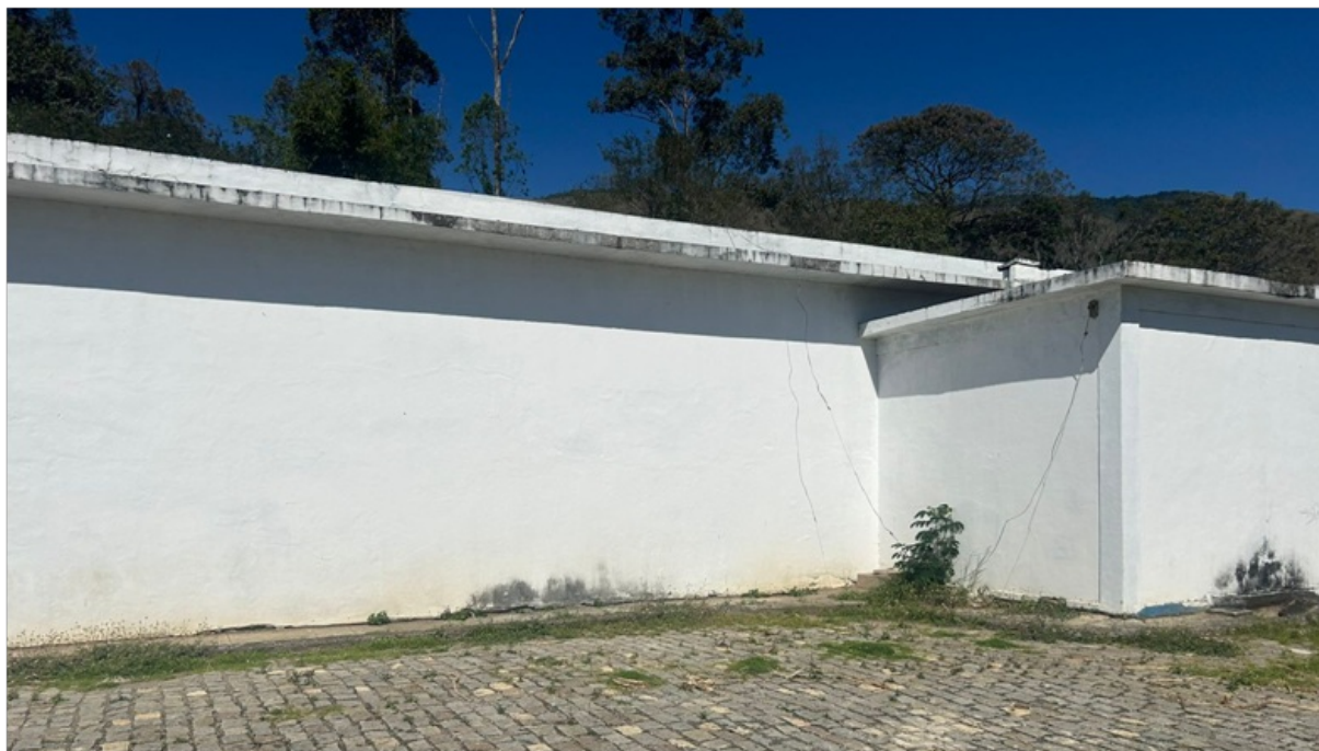
Foto 1 – Vista lateral do reservatório
