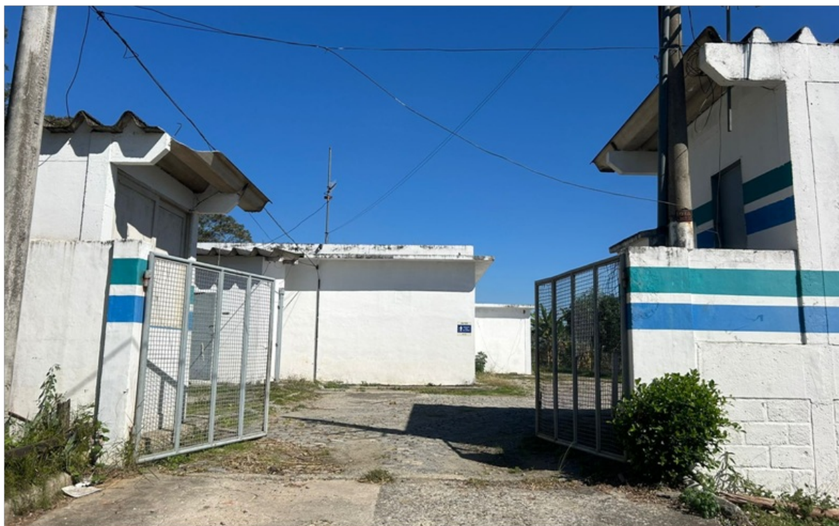
Foto 3 – Vista frontal do reservatório
