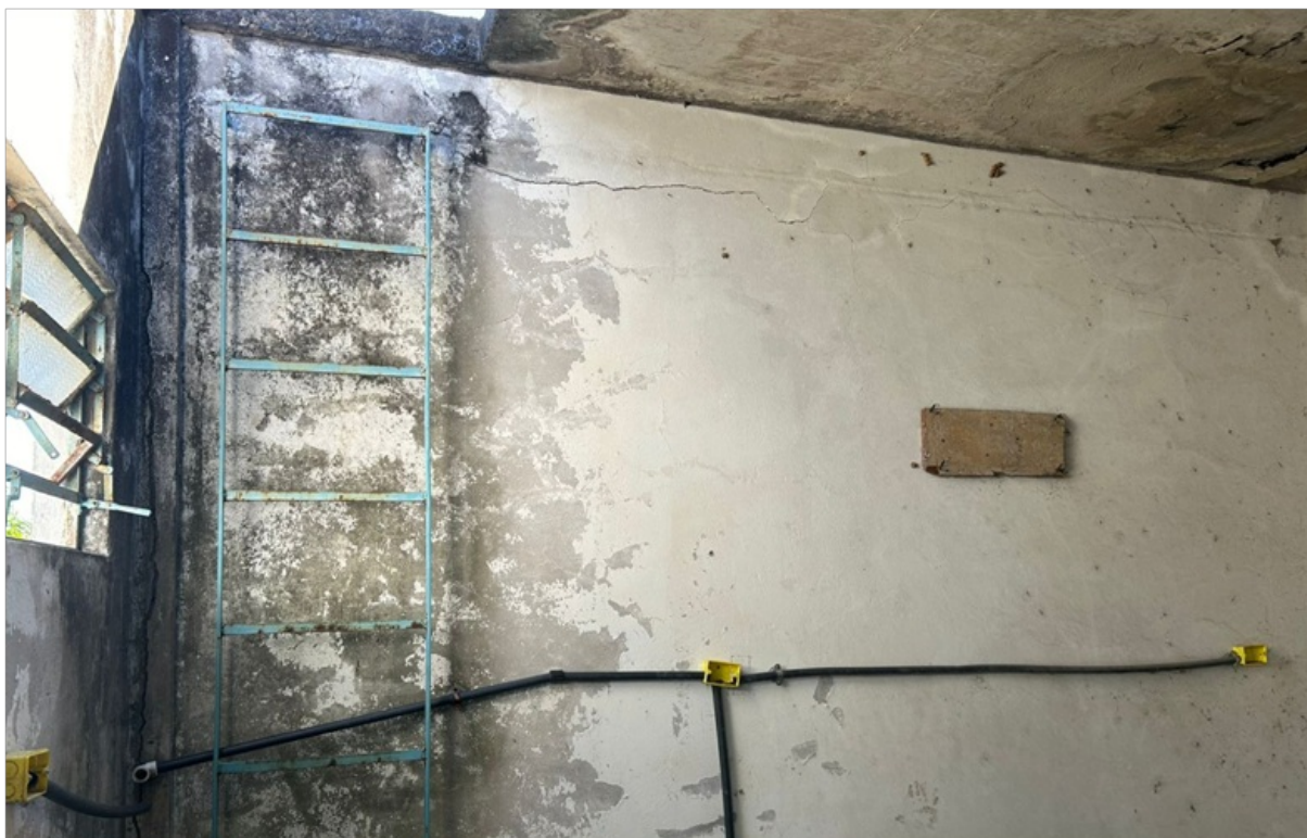
Foto 6 – Escada sem proteção
