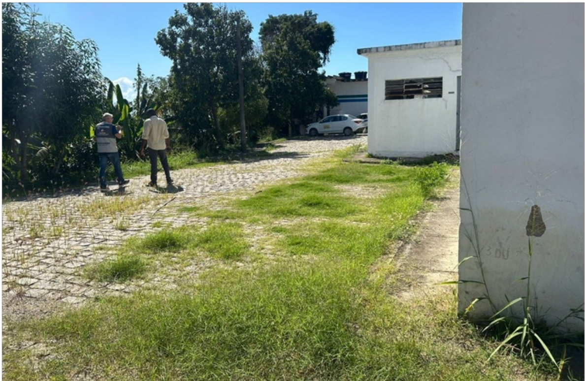
Foto 10 – Vegetação (capim) avançando no pátio em torno do reservatório
