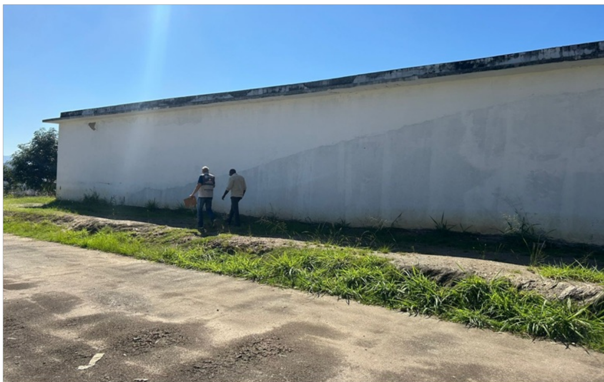
Foto 2 – Vista dos fundos do reservatório
