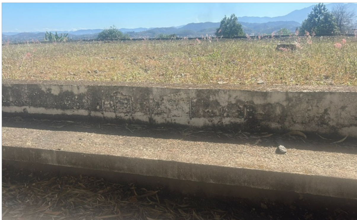
Foto 14 – Vegetação na parte superior do reservatório
